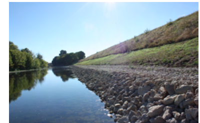
L'enrochement de Mareau-aux-prés aval (45)
