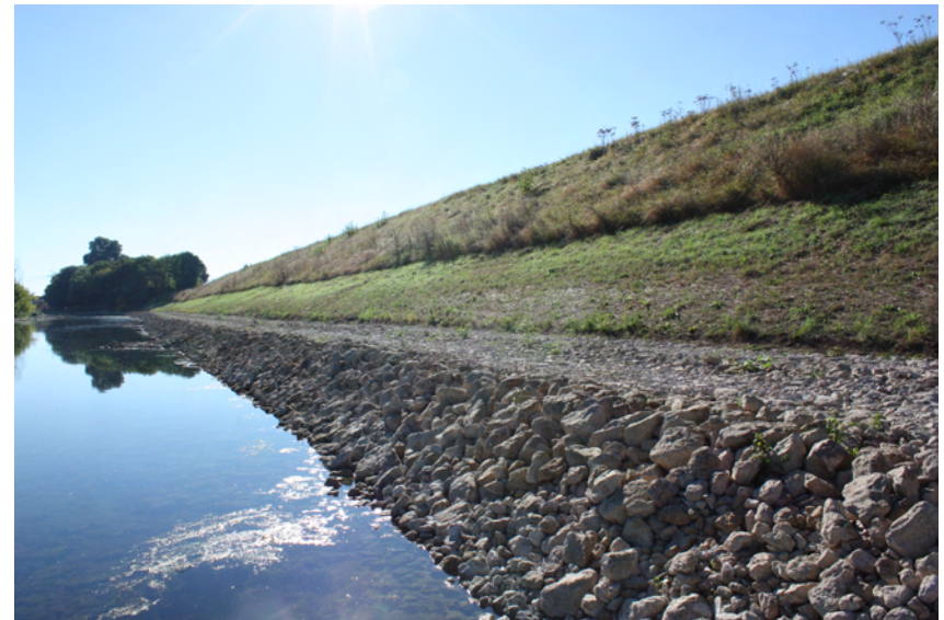
Végétation limitant l'analyse topographique d'une partie du talus – Mareau-aux-prés (45) le 07/09/16 - Cerema
