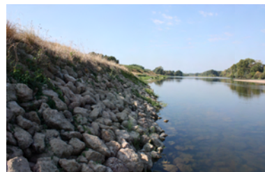
L'enrochement de Saint-Pierre-des-Corps (37)
