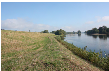
L'enrochement d'Amboise Rive droite aval (37)
