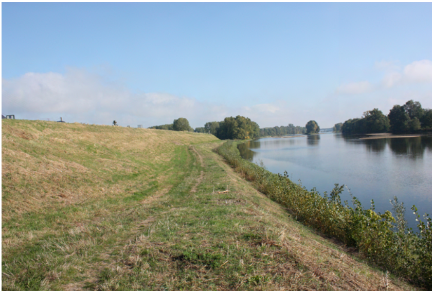
Tonte permettant l'analyse topographique du talus - Amboise (37) le 11/10/16 - Cerema
