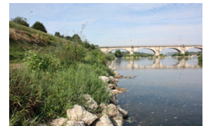
L'enrochement de Montlouis-sur-Loire Saint-Brice (37)
