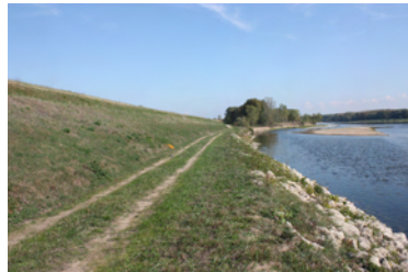
L'enrochement de la Brèche (Veuves 41)
