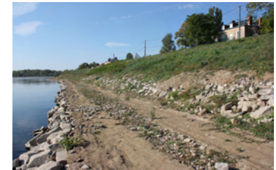
L'enrochement de Givry (Cours-les-Barres, 18)
