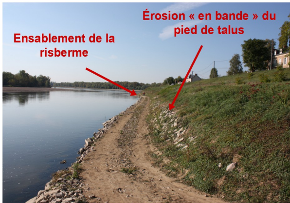
Illustration 9 : Désordres sur la partie aval de l'ouvrage - Cerema - 10/10/16
