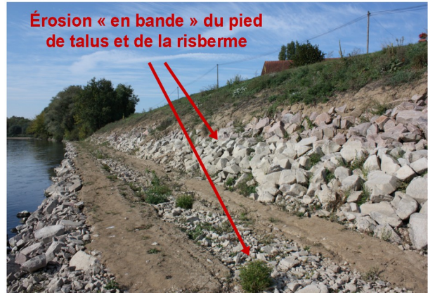
Illustration 10 : Désordres sur la partie aval de l'ouvrage - Cerema - 10/10/16
