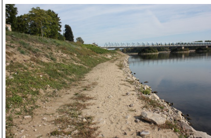
Illustration 13 : Ensablement en partie aval de l'ouvrage - Cerema - 10/10/16
