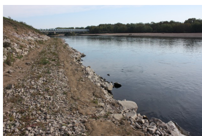
Illustration 6 : Encoche d'érosion n°1 - Cerema - 10/10/16
