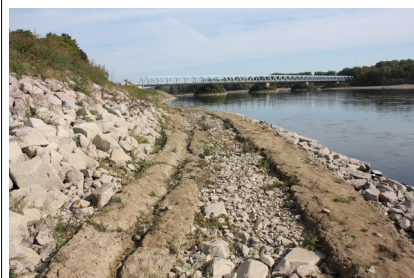
Illustration 12 : Érosion en bande du pied de talus et de la risberme en partie centrale de l'ouvrage - Cerema - 10/10/16
