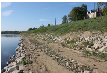
Illustration 11 : Érosion en bande du pied de talus en partie aval de l'ouvrage - Cerema - 10/10/16
