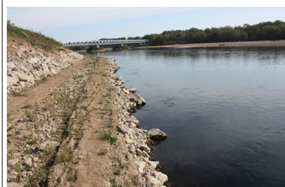
Illustration 8 : Encoche d'érosion n°2 - Cerema - 10/10/16
