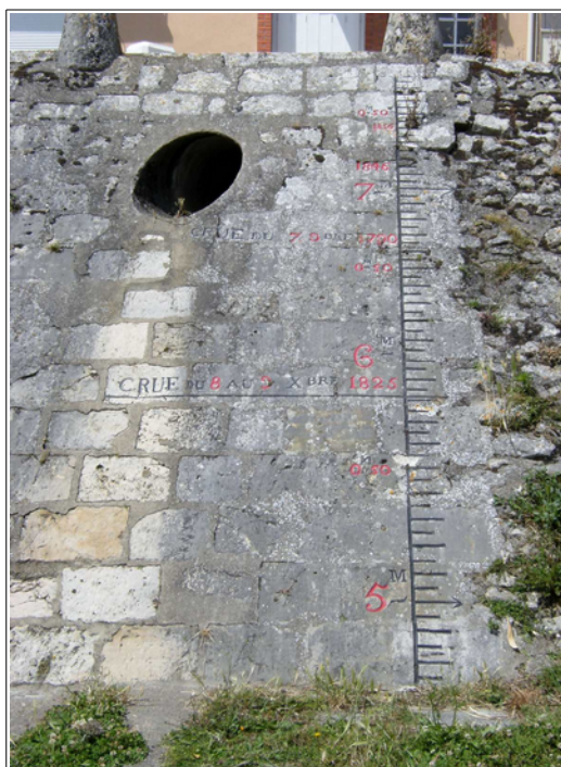
Figure 1 : Échelle avec repères de crues à Châteauneuf-sur-Loire (Source : DREAL Centre-Val de Loire)
