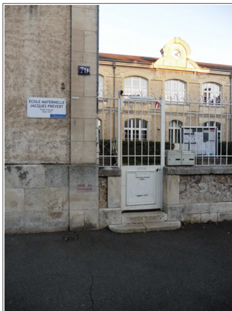
Figure 5 : Repère de la crue du 20 octobre 1846 à Orléans (rue Saint-Marceau)
