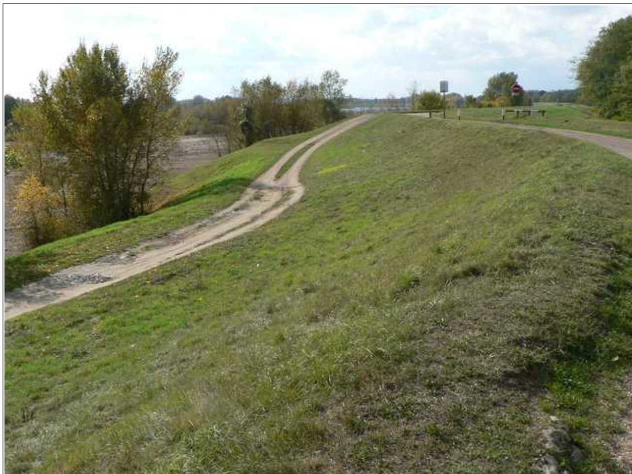
Figure 4 : Levée de la Loire à Jargeau (Source : DREAL Centre-Val de Loire )
