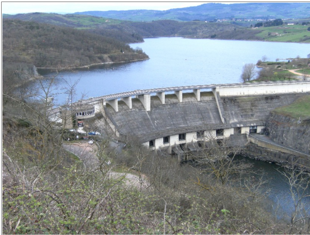
Figure 4 : Vue du barrage de Villerest
