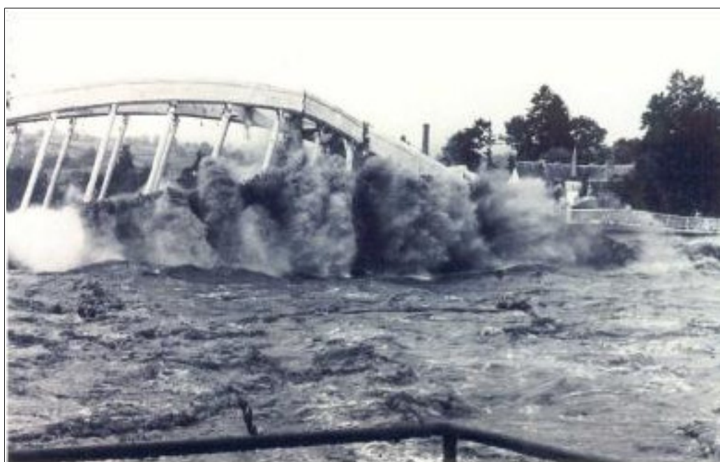
Chute du pont de Coubon en septembre 1980
