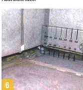
5 et 6 Tassements de dallage (stabilisés et évolutifs) : systématiser les vides sanitaires ou les vraies dalles portées.
