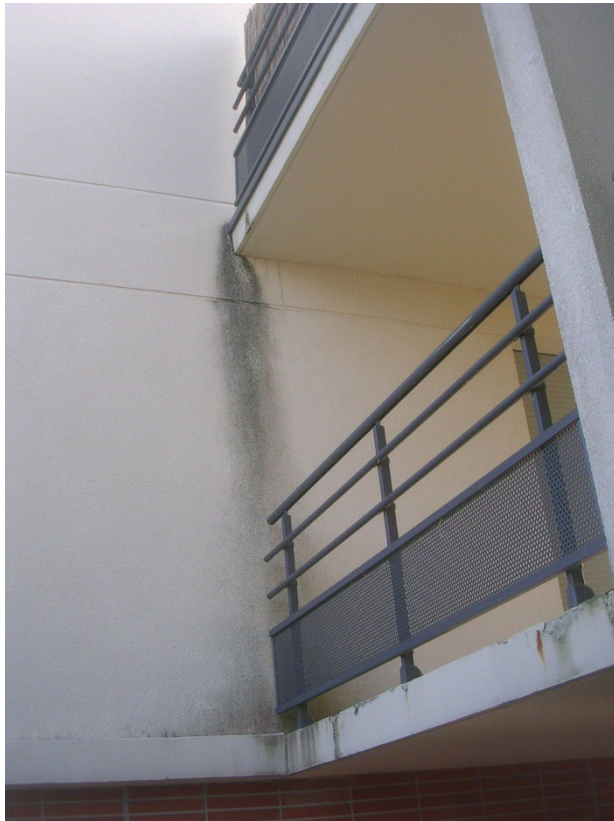
Absence de traitement des rives de balcons
