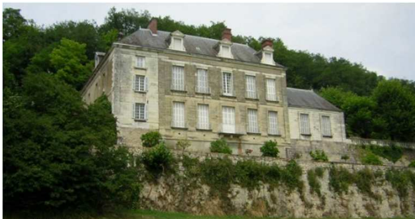
La façade Sud de la maison de maître.
