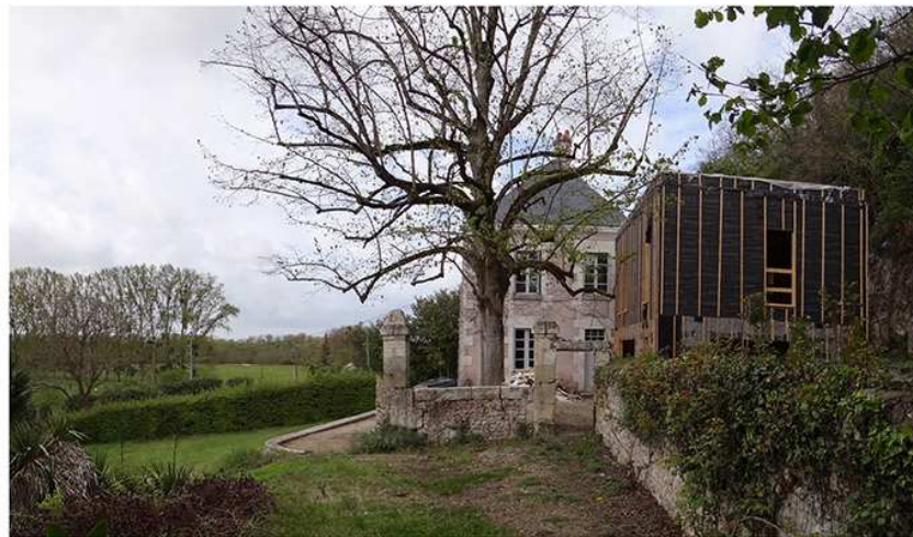
Le pavillon et l'extension contemporaine en construction, vus depuis l'Est (limite de propriété).
