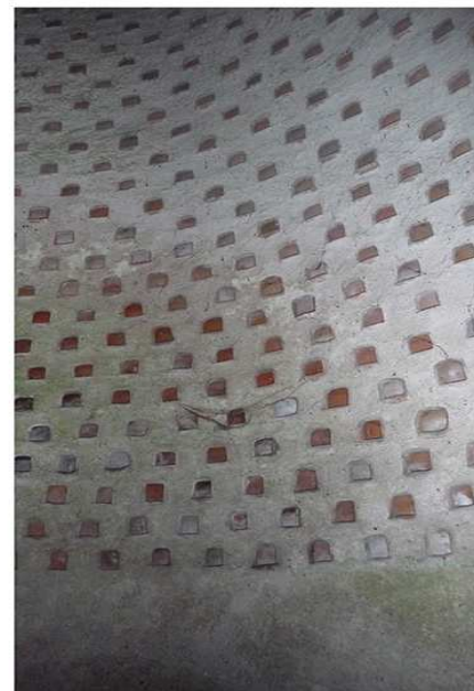
Intérieur : charpente, mécanisme et boulins.
