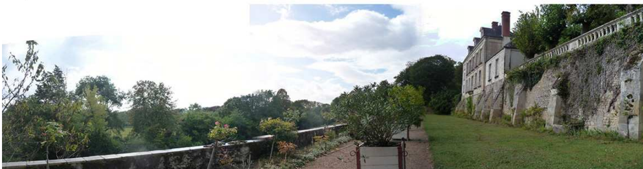
La terrasse inférieure et le mur de soutènement de la plate-forme.
