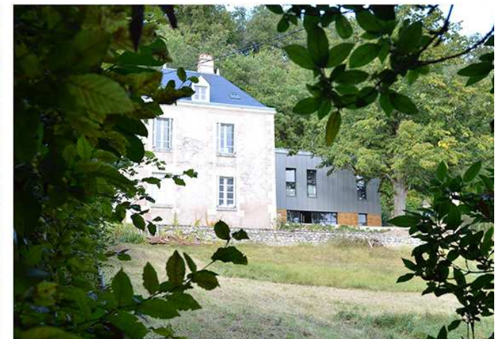
Le pavillon vu depuis l'allée d'accès, avec l'extension achevée.
