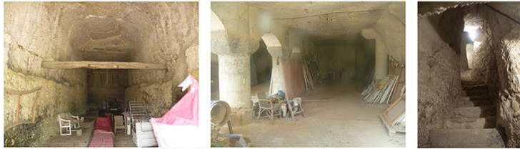
Aperçu de l'intérieur de certaines caves, et escalier dans le roc.
