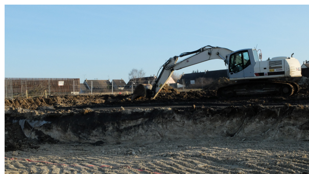
Décapage du sol lors d'une opération immobilière ©DREAL Centre-Val de Loire
