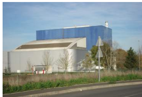
Traitement des ordures ménagères Source : DREAL Centre-Val de Loire
