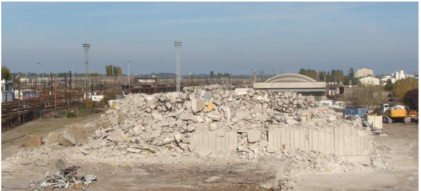
Chantier de démolition à Saint-Pierre-des-Corps
