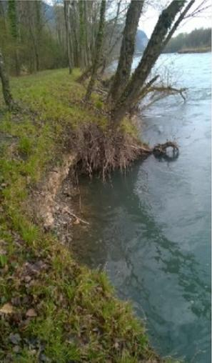
Ansés d'érosion avec arbres couchés + fissures en crête sur le franc-bord
