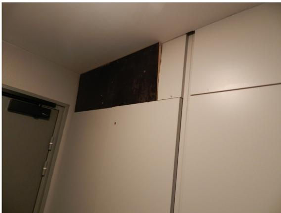
*Paroi d'une gaine technique comportant un élément en bois en partie haute (degré CF altéré)*
