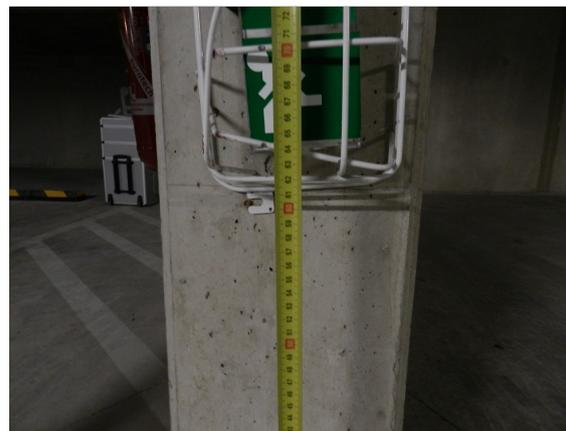
**Bloc lumineux placé en partie basse situé à plus de 0,50 m du sol**
