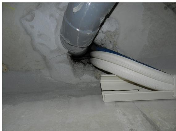
***Percements au niveau du plancher séparant le parc du niveau supérieur altérant le degré coupe-feu***
