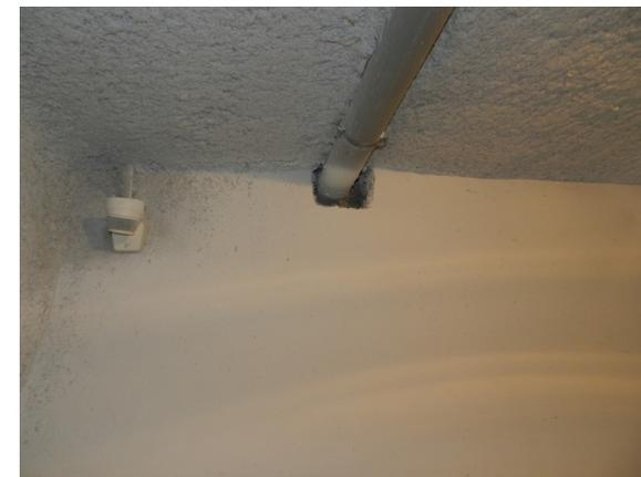
***Percement au niveau d'un mur séparant le parc d'un sas***
