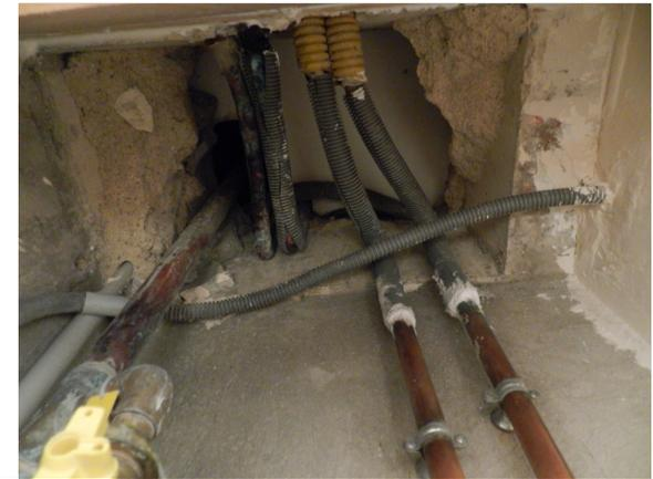
*Recoupement de gaines non réalisé*
