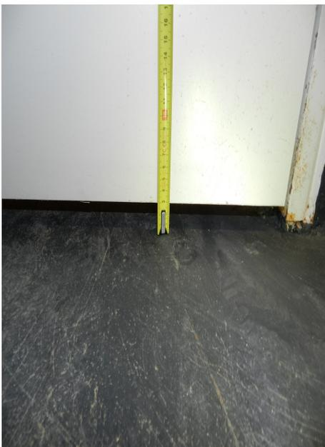
***Détalonnage trop important d'une porte d'un sas détériorant le degré PF***
