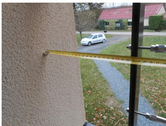
**Espace entre la façade et l'élément vertical trop important (> 11 cm) => remarque vis à vis de la norme**
