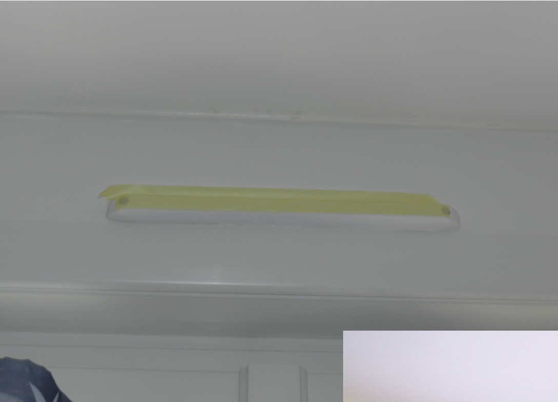
Entrée d'air obstruée
