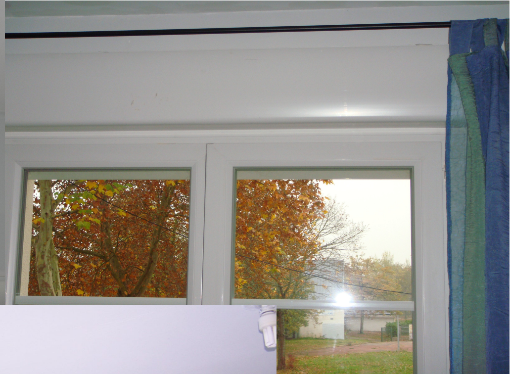
Absence d'entrée d'air
