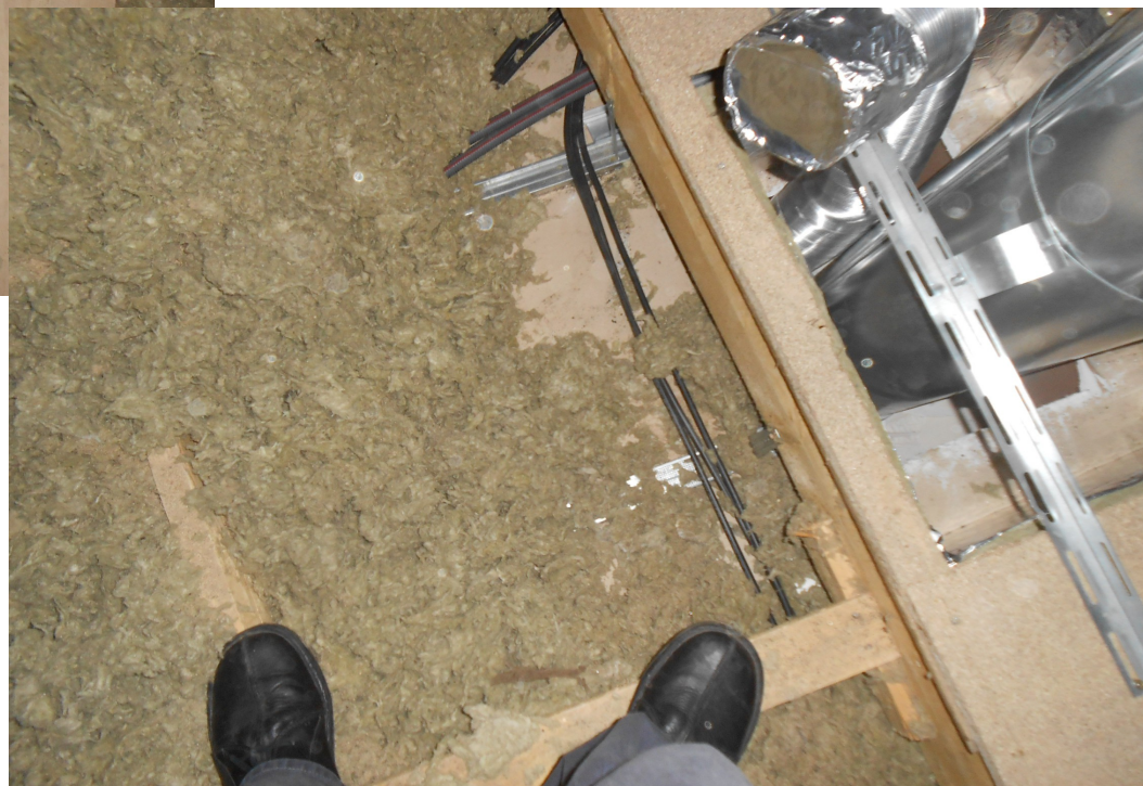
Absence d'isolant sur plafond
