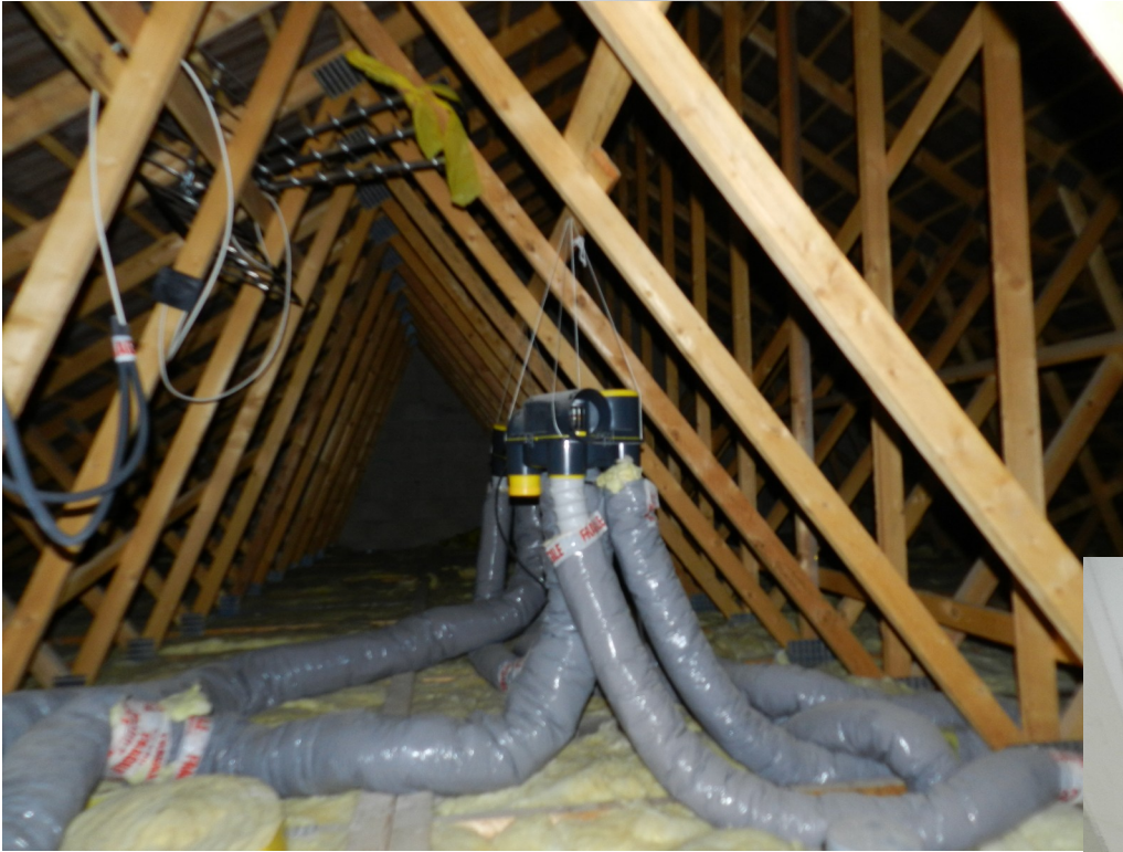
Groupe de ventilation non raccordé
