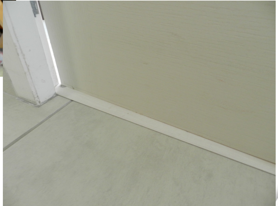
Détalonnage de porte non réalisé
