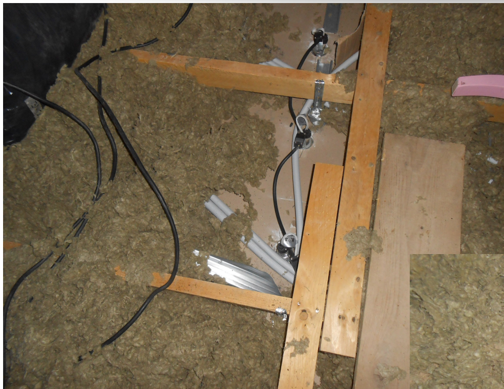
Absence d'isolant sur plafond
