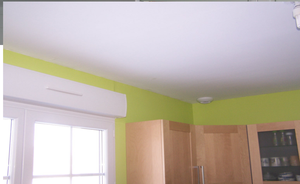
Entrée et extraction dans une même pièce
