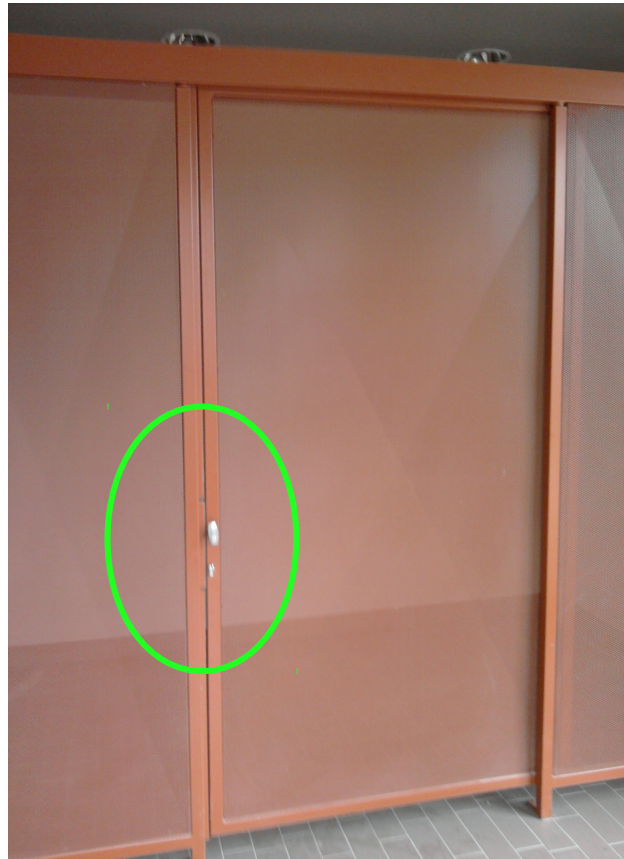
Poignée de porte difficilement manoeuvrable
