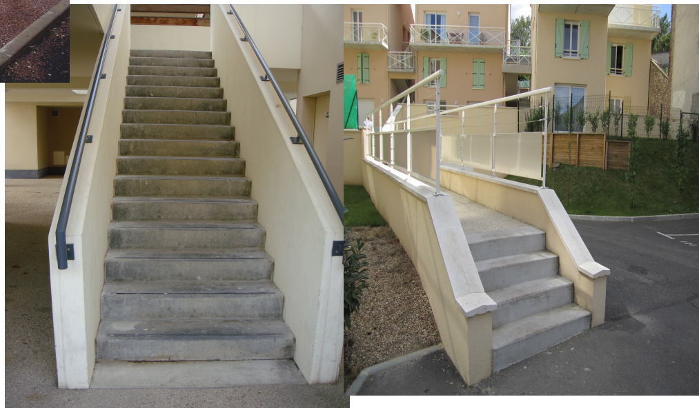
Absence visuel des nez de marches/ contre-marches/ appel de vigilance/mains courantes
