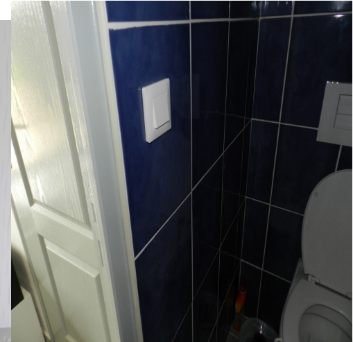
Absence de prise de courant (WC cuisine/séjour/chambre adaptée, Sdb)
