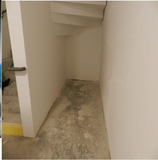
Absence de protection sous escalier
