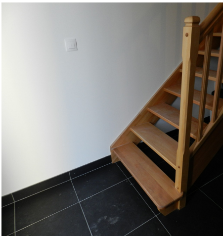
Absence de main courante/prolongement
