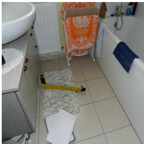
Espace libre insuffisant Sdb/WC
