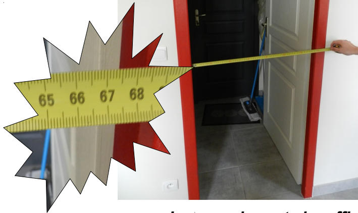
Largeur de porte insuffisante
