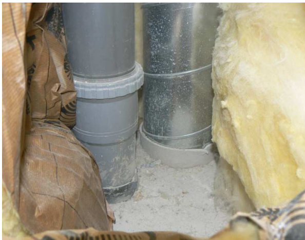
Défaut d'isolation de la gaine technique
