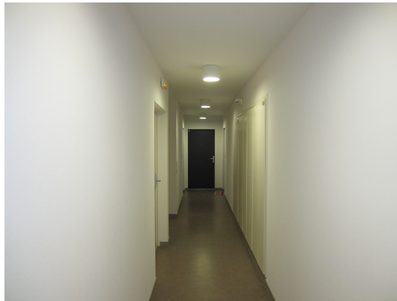
Absence de revêtement absorbant
