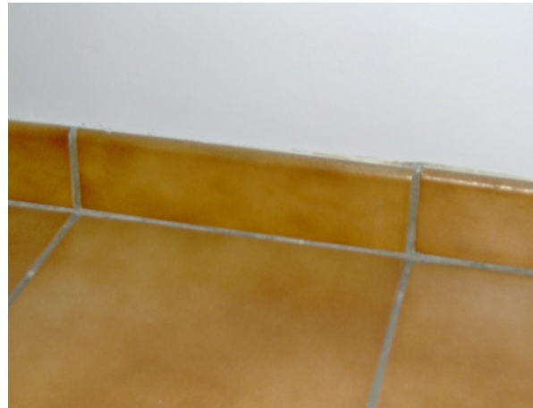
Plinthes collées sur le carrelage
