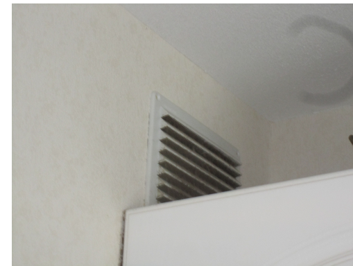
Bouche VMC non nettoyée
