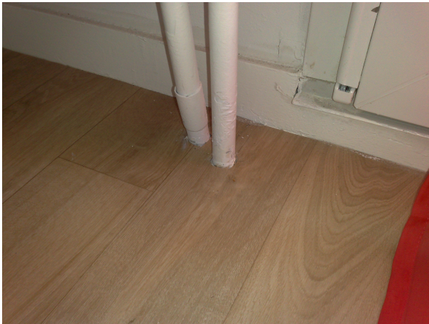
Traversée de plancher
