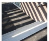
6. Marches isolées sur cheminement non isolées et donc non repérées par les déficients visuels: effet trompeur des arêtes d'une marche.
