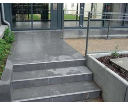
7. Traitement incomplet de marches isolées sur un cheminement (absence d'éveil de vigilance, contremarches d'extrémité non contrastées).
