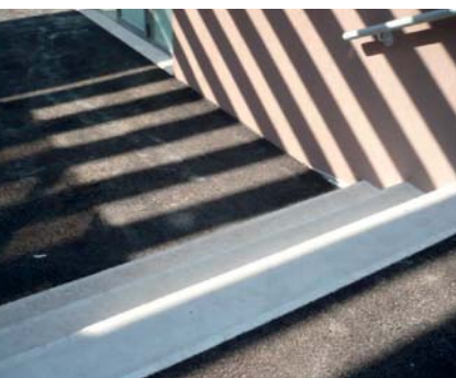
6. Marches isolées sur cheminement non traitées et donc non repérables par les déficients visuels; effet trompeur des ombres d'une pergola.
