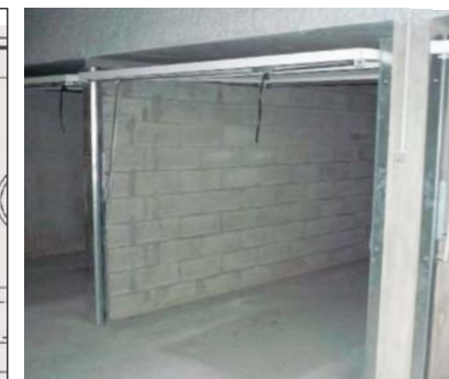
9. Porte de box non manœuvrable par des personnes à mobilité réduite y compris en fauteuil roulant (effort d'ouverture, atteinte des commandes).
