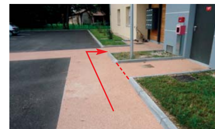
4. Rupture du guide (bordure trottoir) pour déficient visuel.
