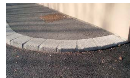
2. Ressaut de plus de 2 cm sur cheminement au droit de la jonction avec la voirie.
