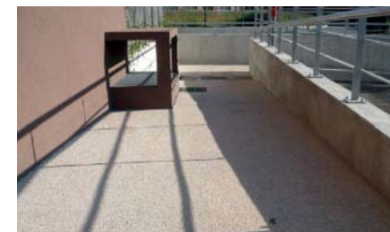
1. Rétrécissement ponctuel et obstacle sur cheminement.
