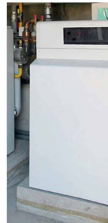
1. Chaudière posée sur un massif béton désolidarisé du plancher.
