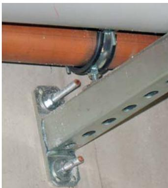
2. Canalisation de chauffage tenue par un collier antivibratile.
