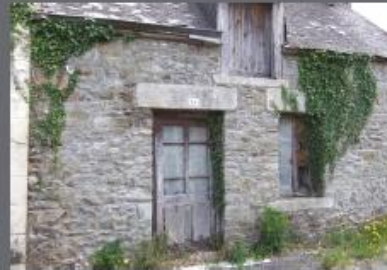
Bâti à l'abandon
