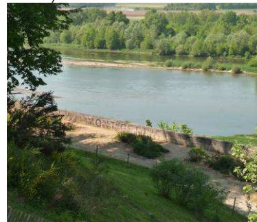
Plate-forme sur laquelle était implantée l'ancienne église.
