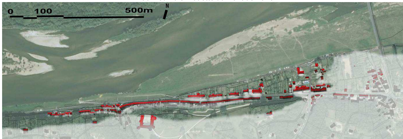
(En couleur : les éléments vus depuis la rive droite)
