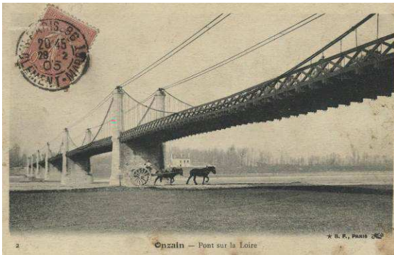
L'ancien pont suspendu.
