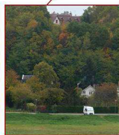
Construction dans le boisement.
