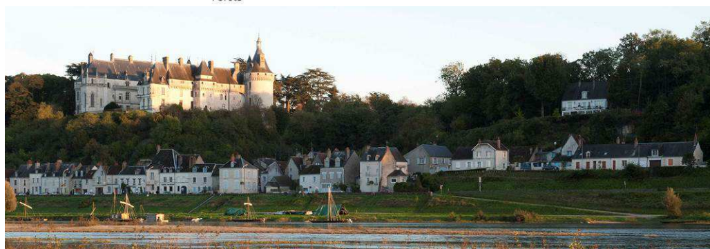
A droite du château : un pavillon émergeant du coteau boisé (construit après 1964).
