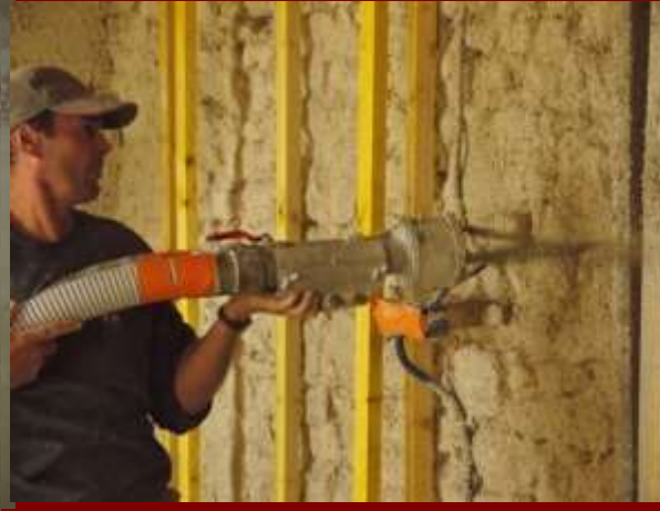
Intérieur : enduits chaux-chanvre en amélioration thermique
