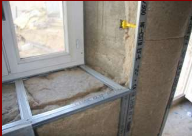
Intérieur : isolation plaquée : isolant biosourcé + film hygrovariable + fermacell
