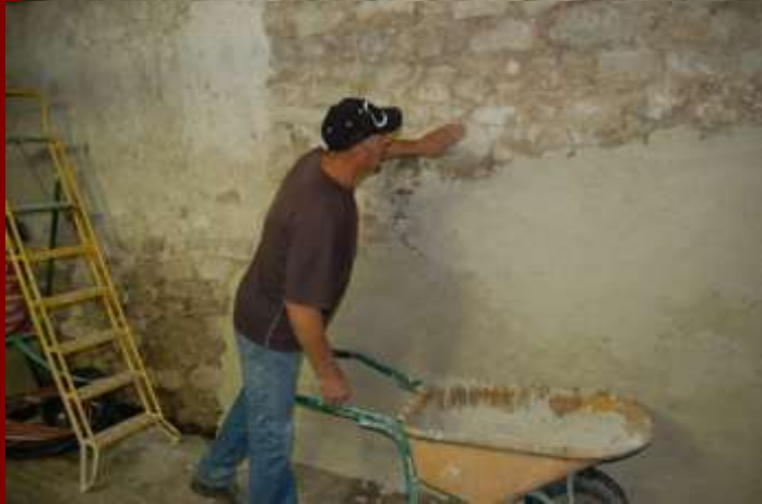
Intérieur : enduits chaux-chanvre en amélioration thermique
