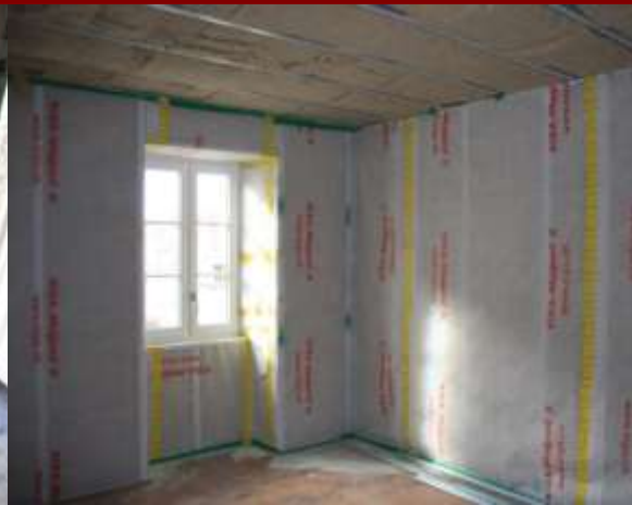
Intérieur : isolation plaquée : isolant biosourcé + film hygrovariable + fermacell
