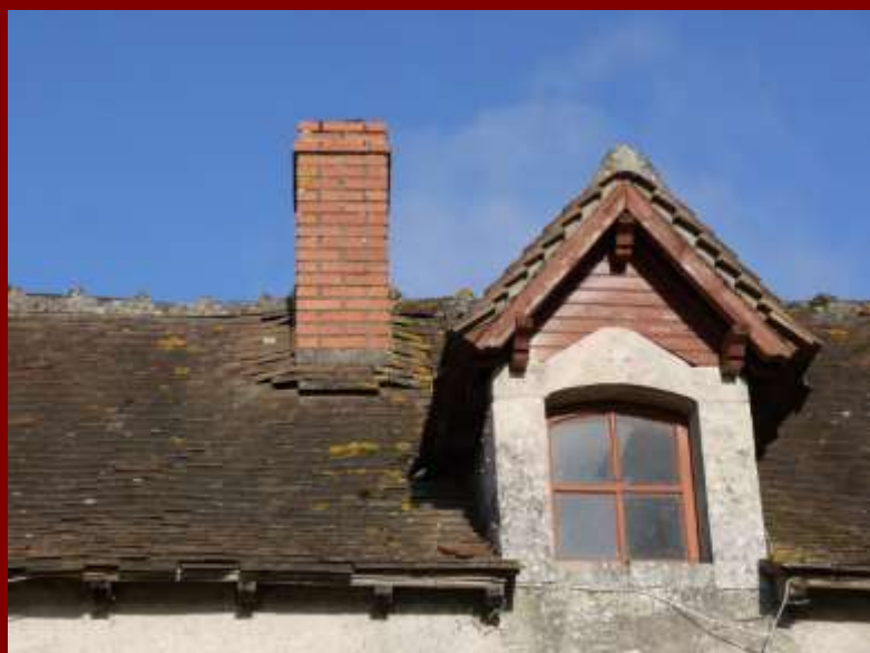
2016 - Etat de dégradation avancé, notamment pignon ouest et couverture
