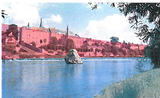
Façade Sud de St Gaultier sur la Creuse.
