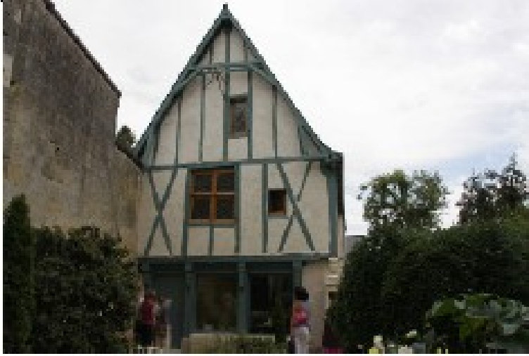
Façade côté nord
