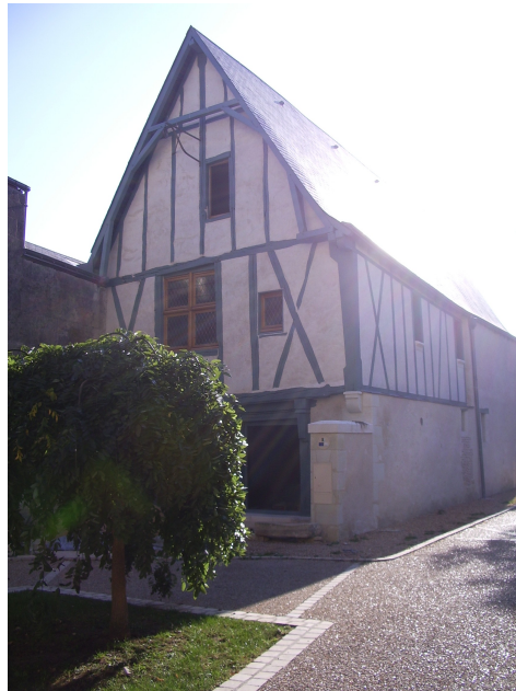
Façade ouest et nord après travaux Photos : Francis GOUAS
