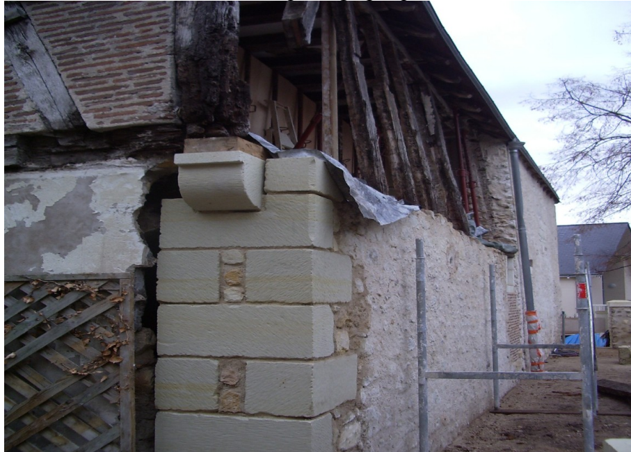
Façade Ouest en restauration (jambages à remplacer)
