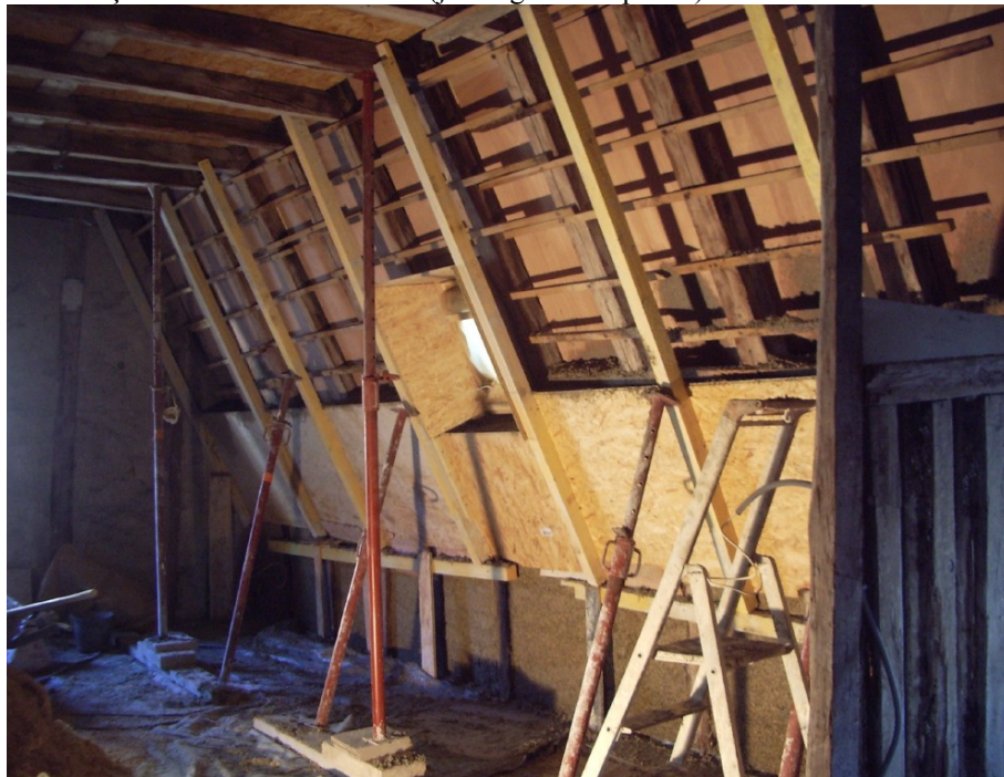
Combles : coffrage pour le béton de chanvre
