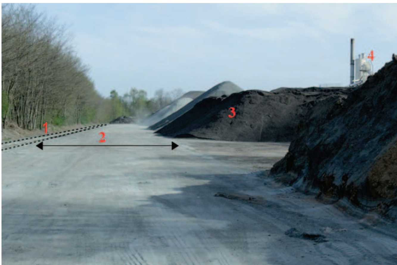
Illustration 10: Orléans Enrobés Sud, vue sur la voie sur site(1), la zone de déchargement(2), la zone de stockage des granulats(3) et la centrale d'enrobage(4); avril 2017 Crédits : Cerema
