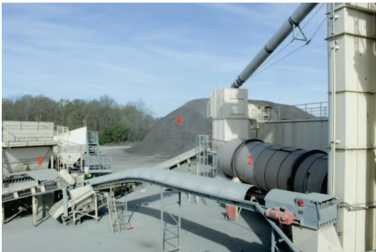
Illustration 9: Orléans Enrobés Sud, vue sur le processus de dosage (1), le tambour de séchage(2) et le stockage de bitume concassé (3) ; Le site peut produire jusqu'à 1600 tonnes d'enrobé par jour. avril 2017. Crédits : Cerema
