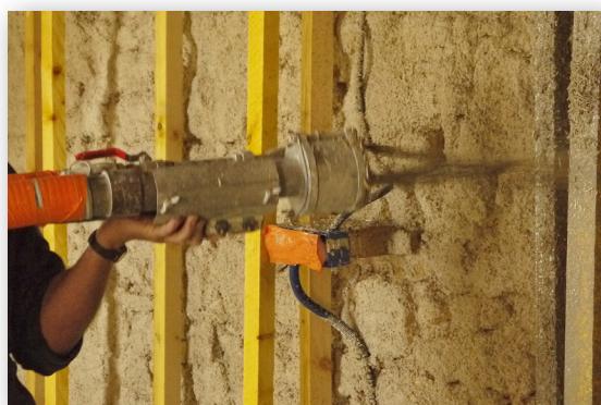
Projection d'un enduit isolant (béton chaux-chanvre).
