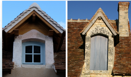
5 Lucarne, jour ou porte, avec jambages en pierre ou en bois, couverte de tuiles.
