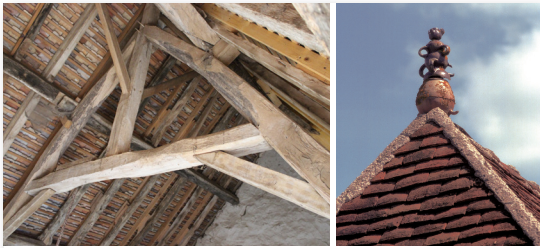
4 Charpente en bois, de chêne, de peuplier et plus rarement d'orme, souvent à entrain retroussé. Tuiles plates en terre cuite plus ou moins galbées avec ergot (ou nez).
