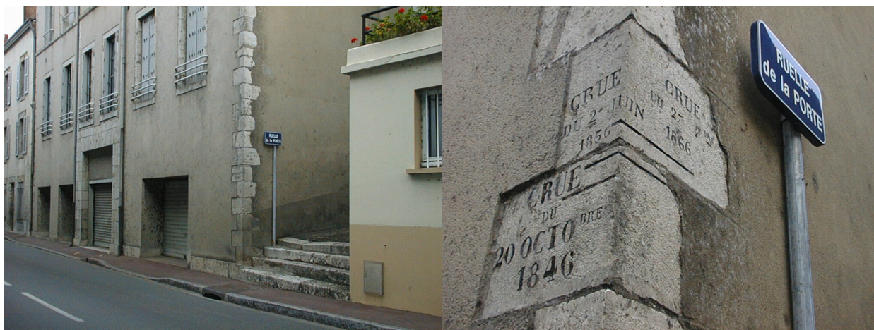
Repères de crues à Gien
