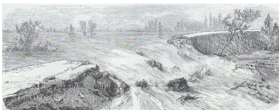
Brèche à Conneuil (Montlouis-sur-Loire)
