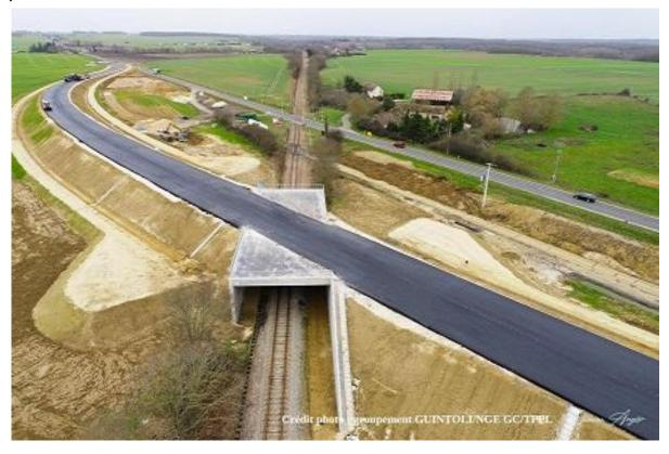
L'ouverture à la circulation de cette infrastructure le 21 avril 2021 signe la fin des travaux de suppression d'un passage à niveau recensé comme dangereux. La suppression du PN144 consiste en la déviation de la RN10 vers l'est du PN actuel et la création d'un pont routier permettant de franchir la ligne ferroviaire Brétigny-La Membrolle-sur-Choisille.
