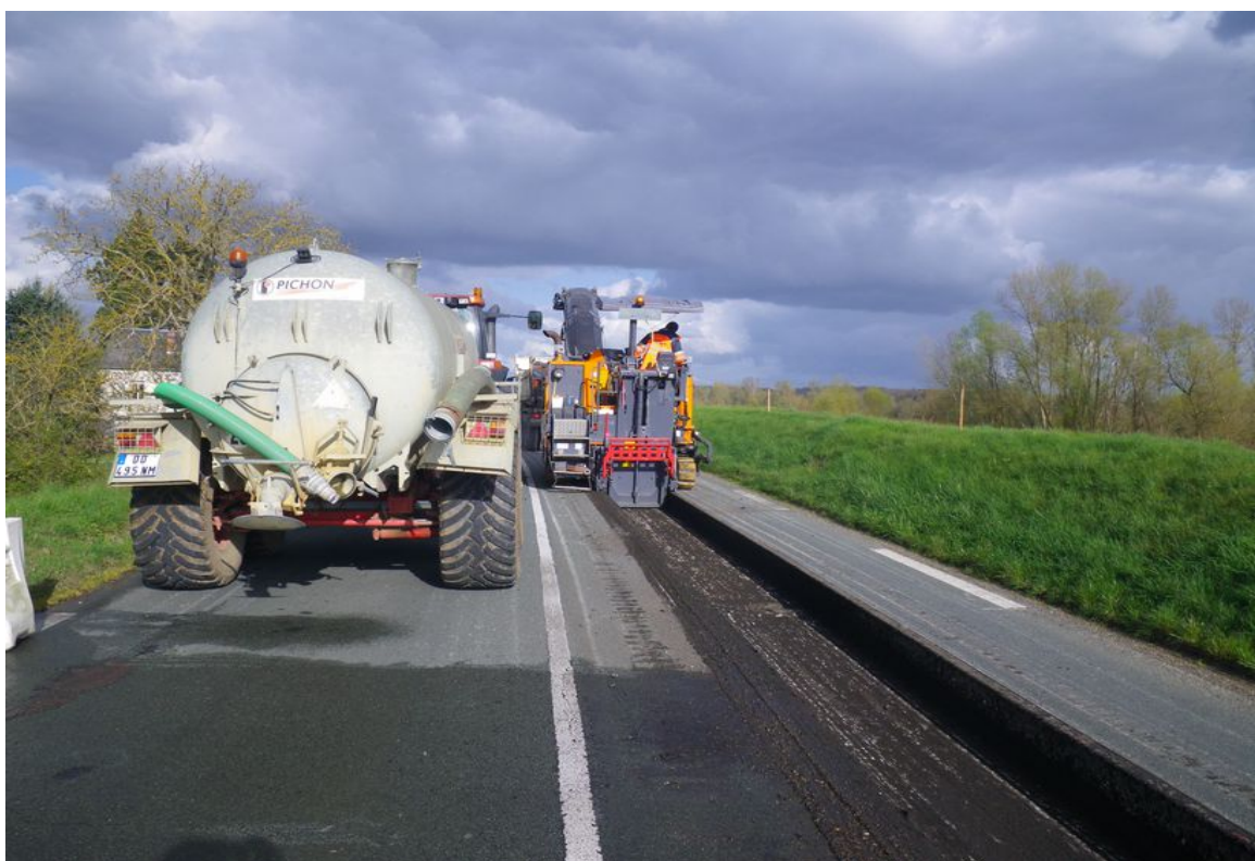
Démolition de la chaussée : Rabotage des premières couches de la chaussée
