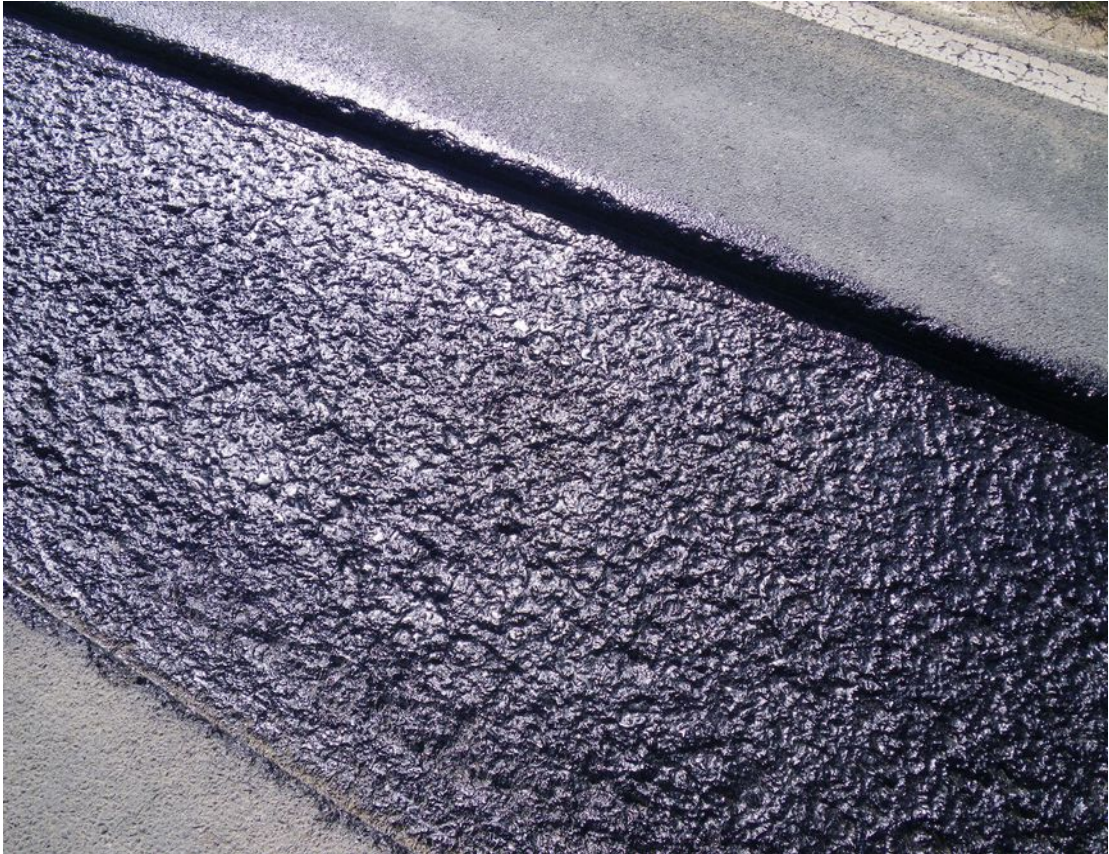
Réfection de chaussée : Couche d'accrochage
