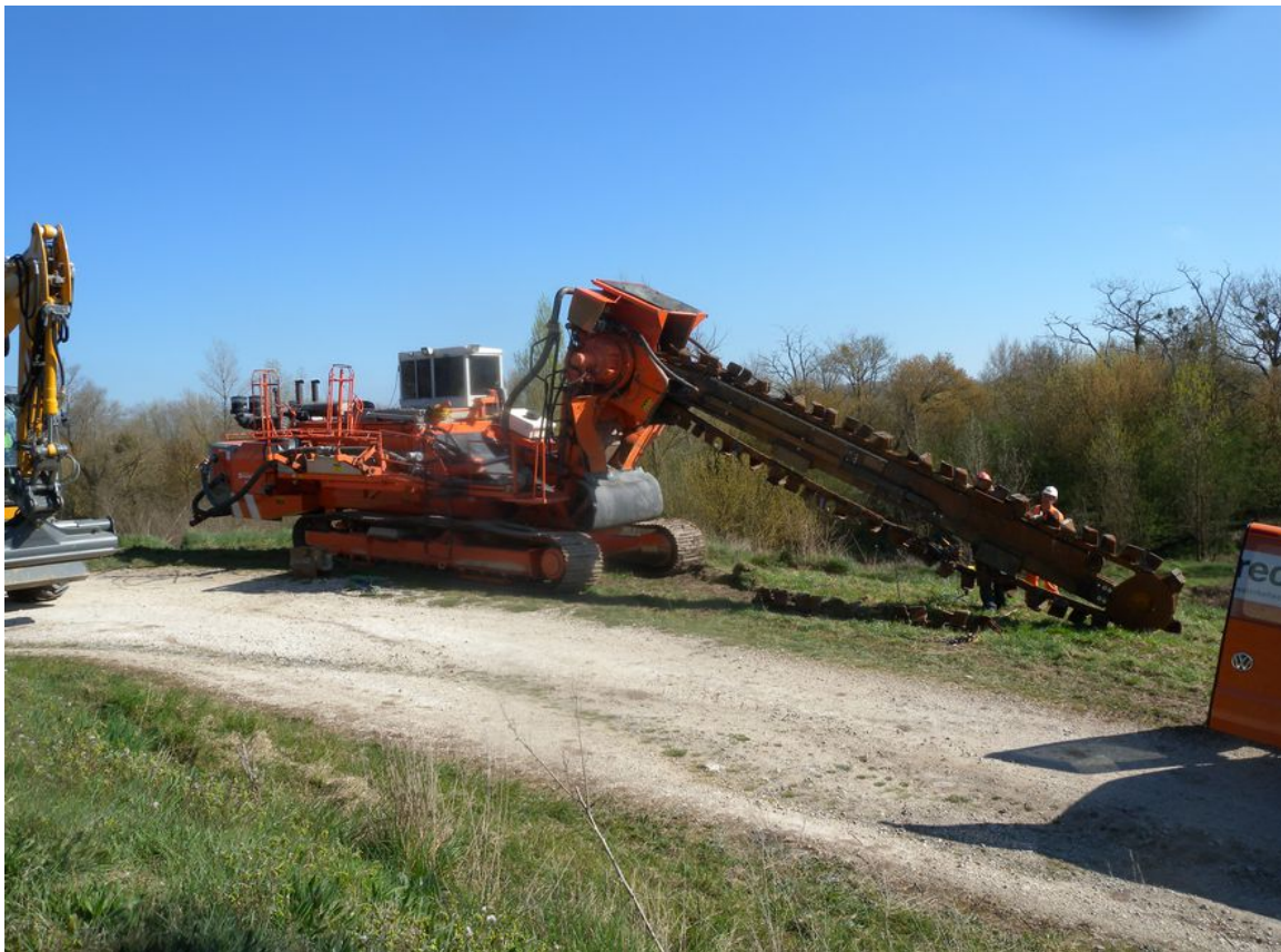
La Trancheuse malaxeuse à son arrivée
