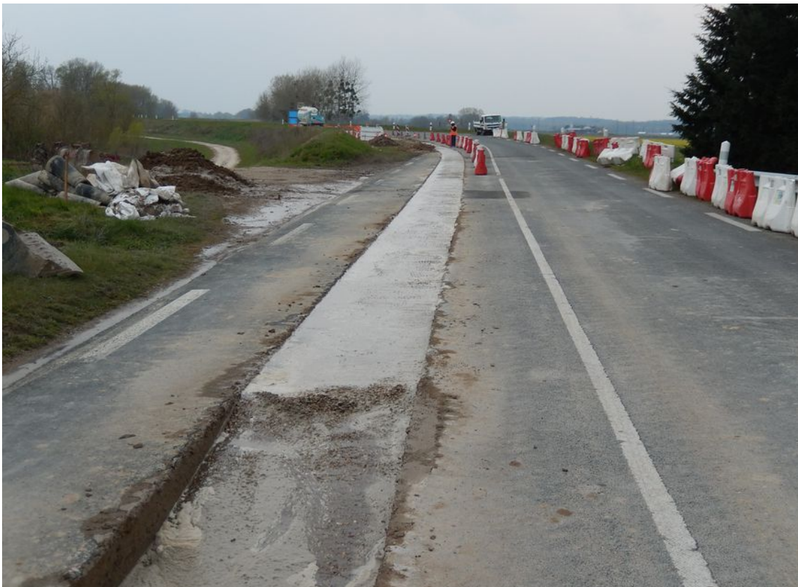
Réfection de la chaussée : Béton de chaussée en cours de séchage
