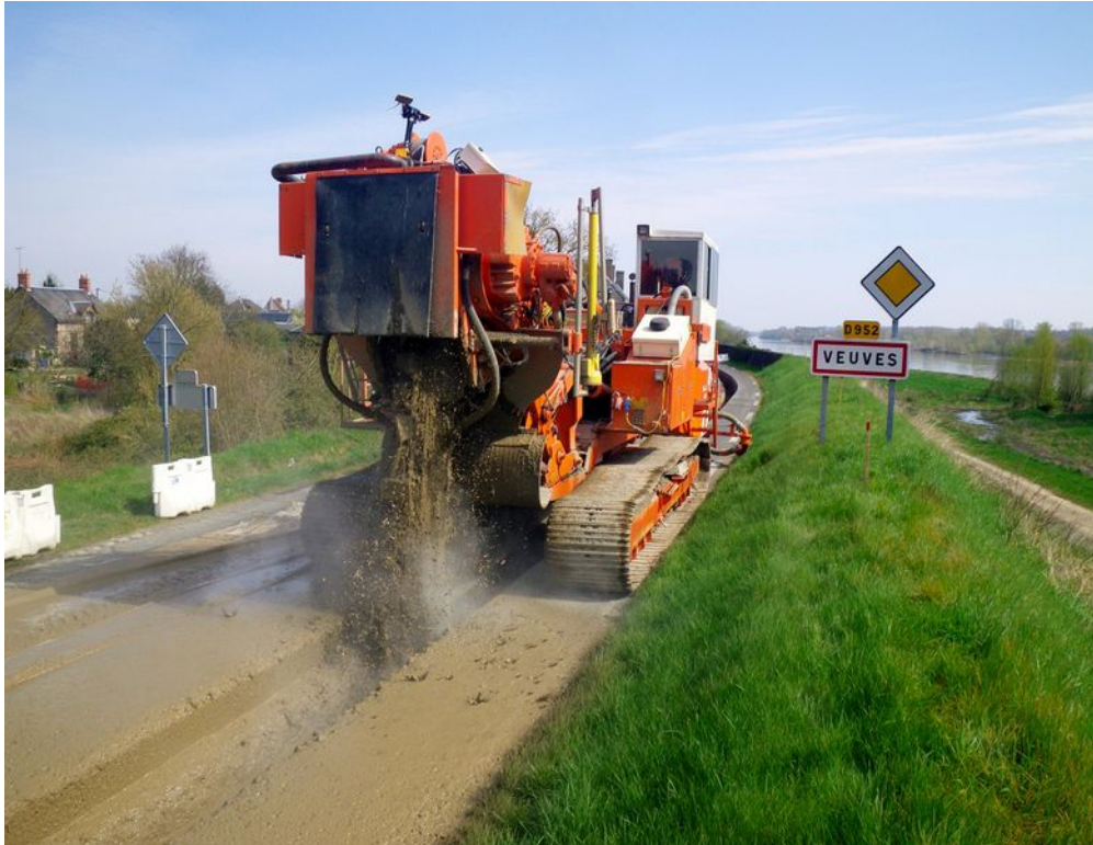
Réalisation de l'écran avec la trancheuse malaxeuse
