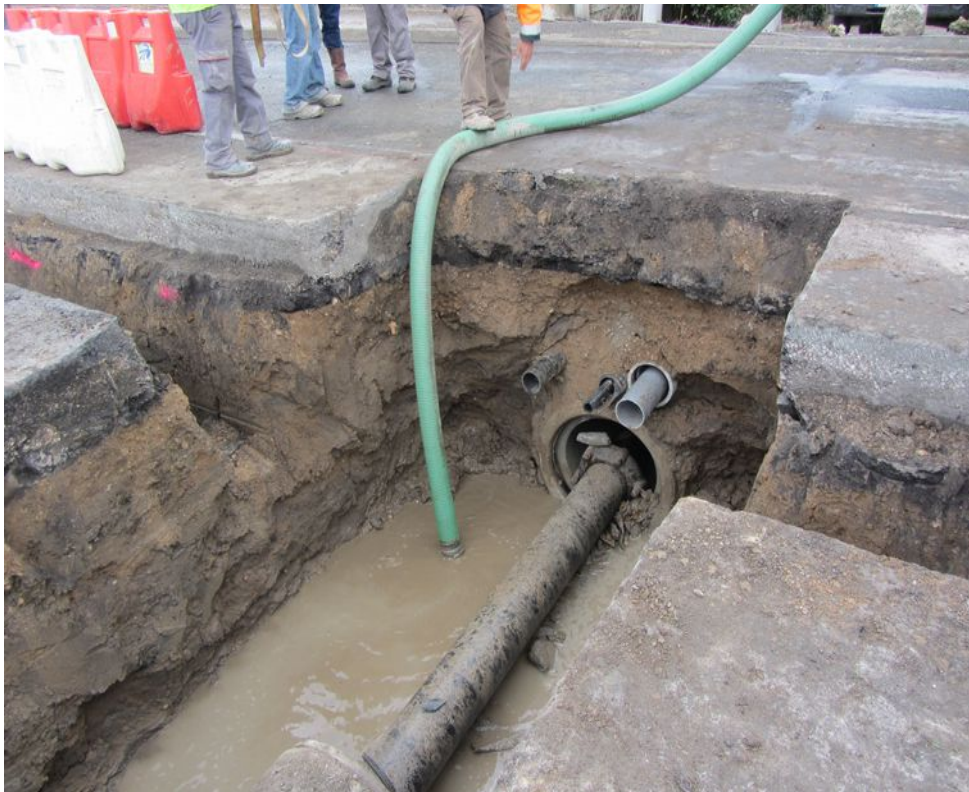
Canalisation eau potable avant son traitement
