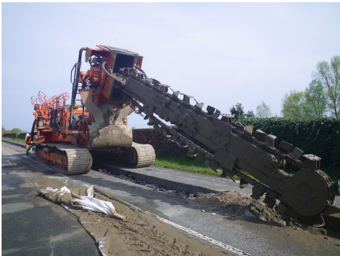
Mise en place de la trancheuse malaxeuse
