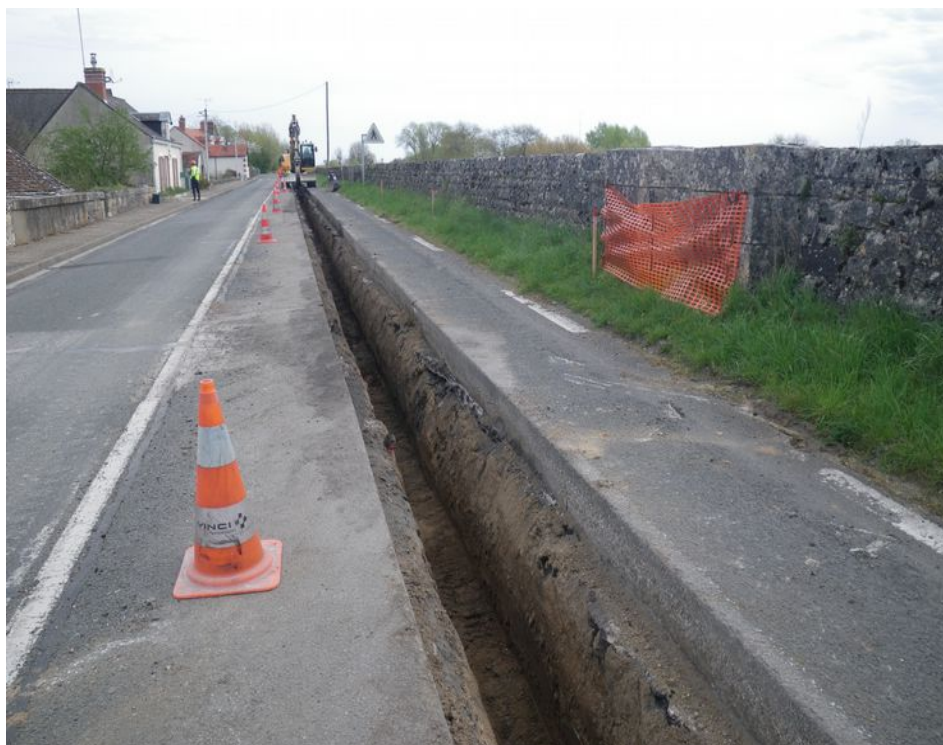
Démolition de chaussée : Pré-tranchée
