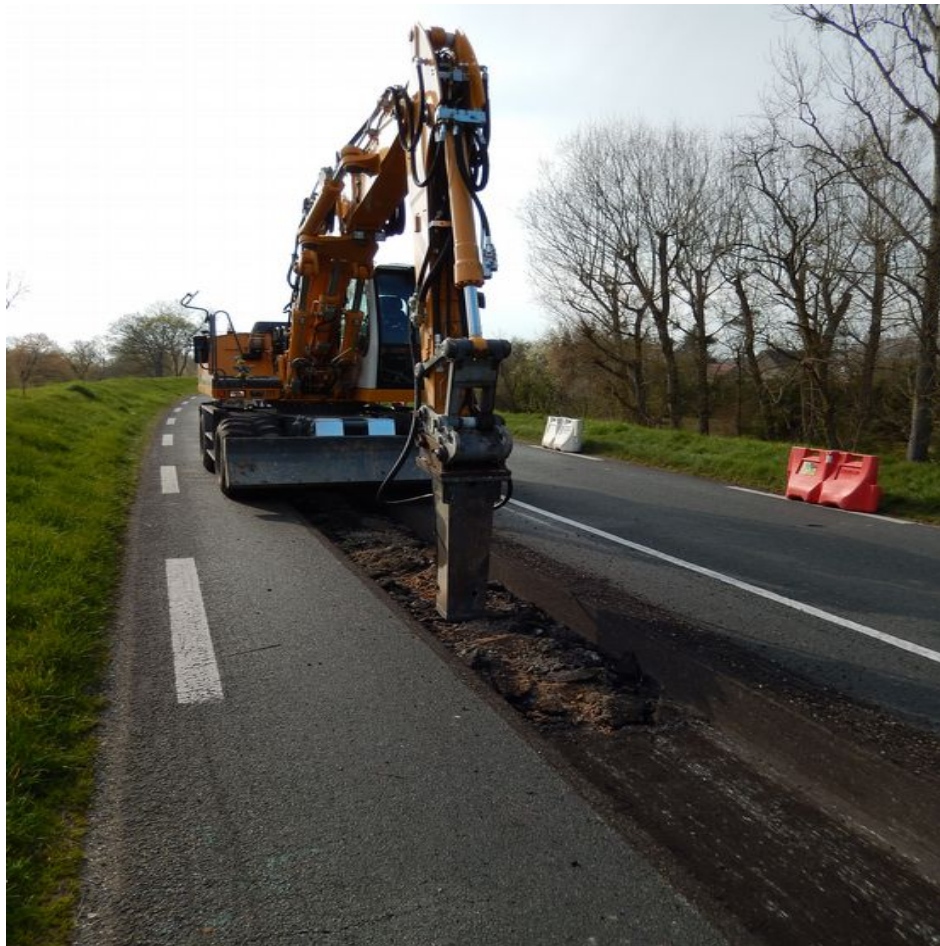
Démolition de la chaussée : Démontage au Brise Roche Hydraulique des couches plus profondes
