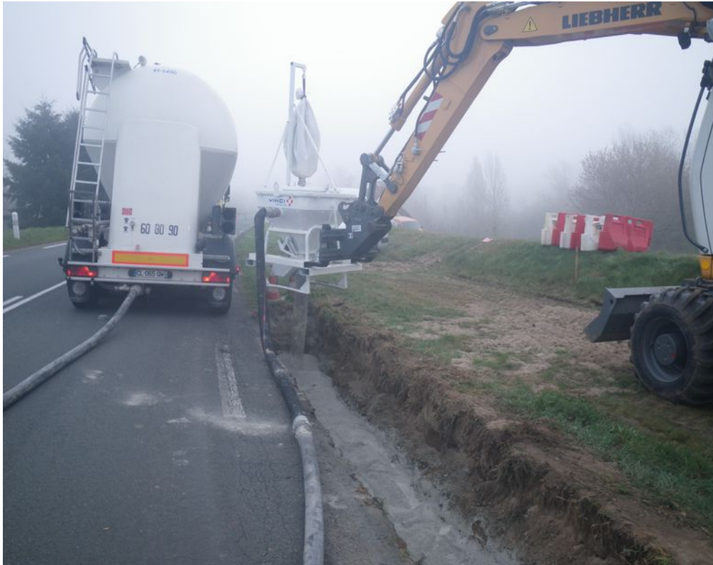
Épandage du ciment
