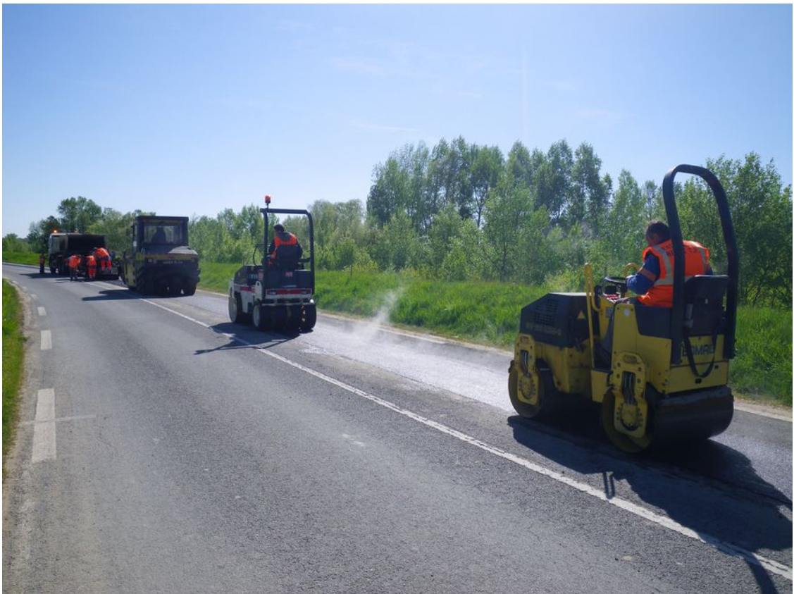
Réfection de la chaussée : Mise en œuvre de l'enrobé bitumineux
