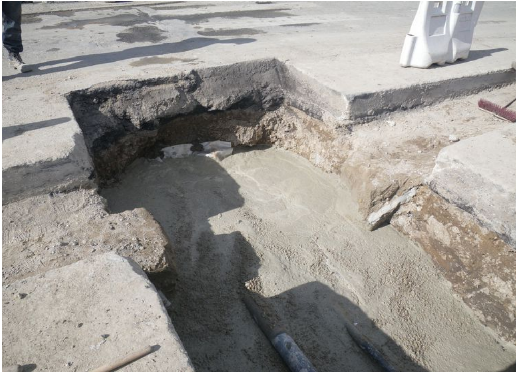
Recouvrement de la canalisation de béton
