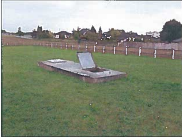
Photographie 1 : Tête du captage de la Ricorne
