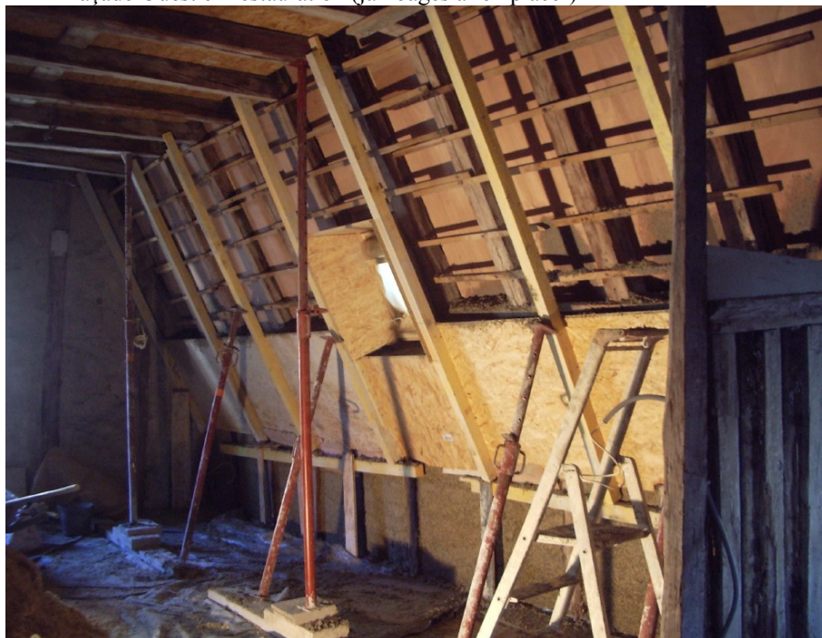
Combles : coffrage pour le béton de chanvre
