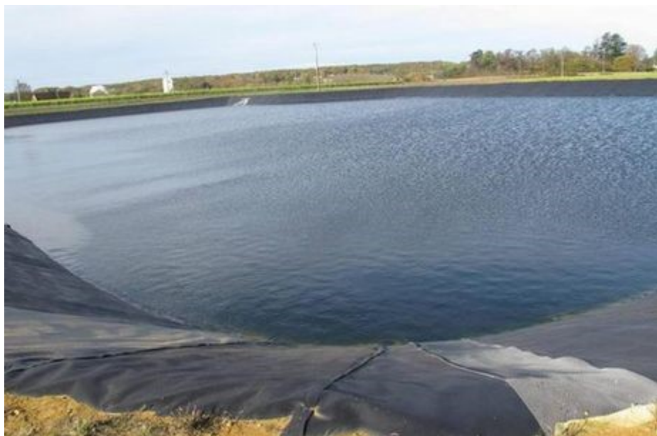
Photo : La Nouvelle République du 29/11/2011
