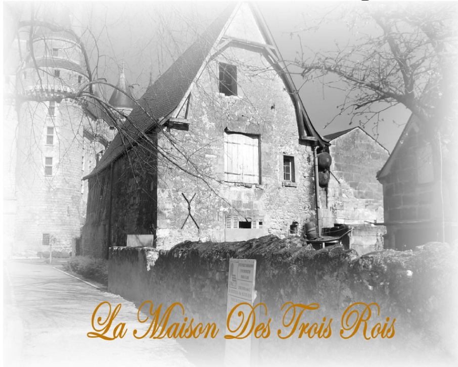
Façades ouest et sud avant travaux
