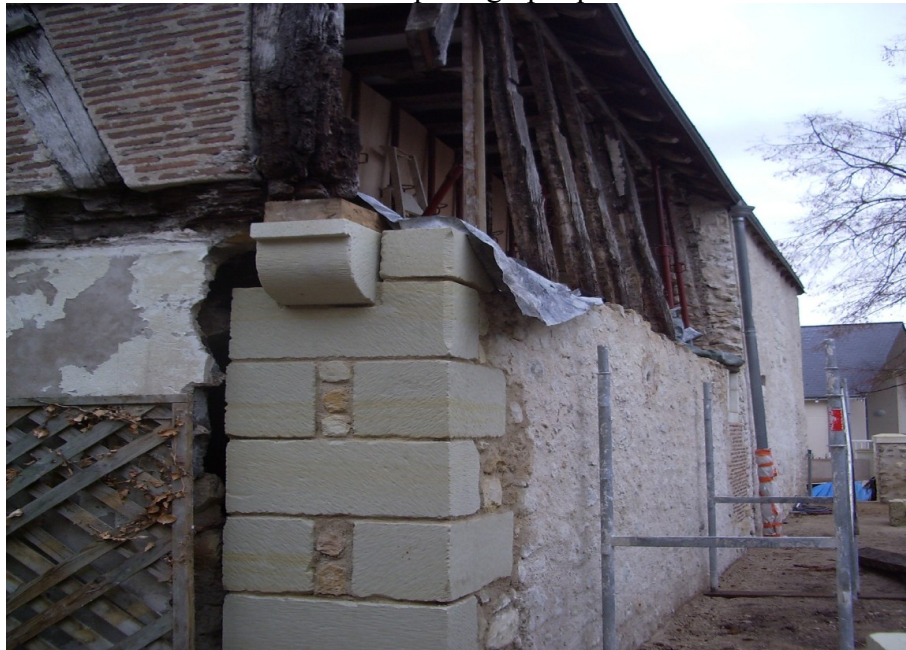
Façade Ouest en restauration (jambages à remplacer)
