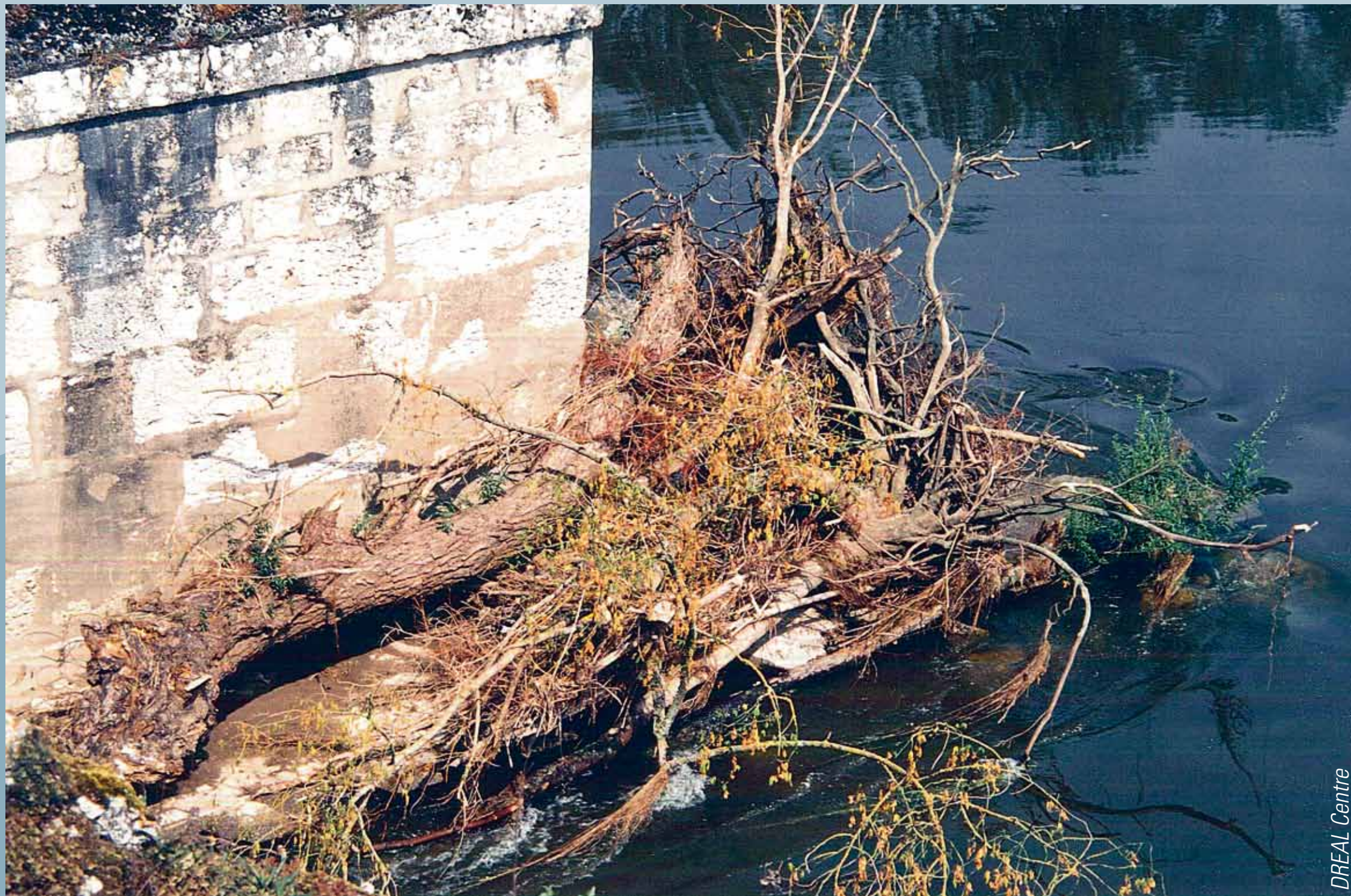
Embâcles accumulés contre un pilier du pont George V
