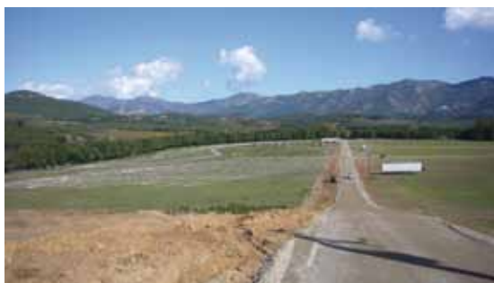
Route et chantier
