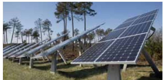
Suiveurs à rotation mono-axiale
