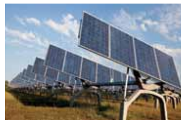
Suiveurs à rotation bi-axiale
