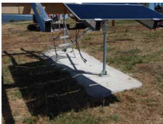
Deux exemples de fondations : fondations avec pieux acier (en haut) et fondations en semelle béton (en bas)
