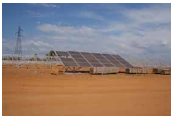
Pose des modules sur les supports
