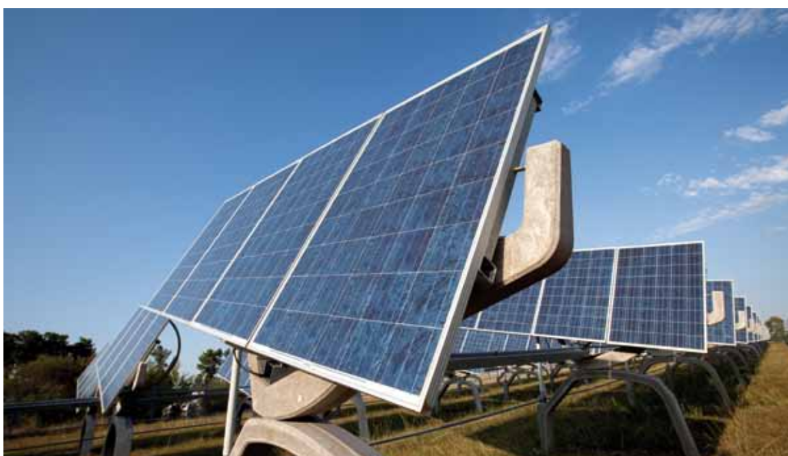
Installation photovoltaïque équipée de suiveurs
