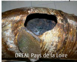
Corrosion en milieu humide par l'H2S
