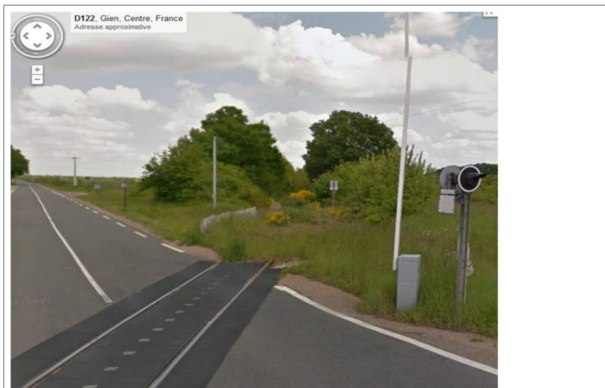
Illustration 1: ITE N°101 : accès à un important site industriel de Georgia Pacific. L'ITE est active mais impraticable
