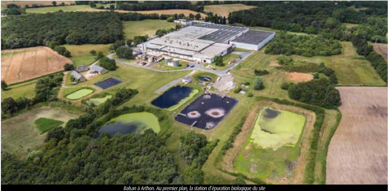
Balsan à Arthon. Au premier plan, la station d'épuration biologique du site
