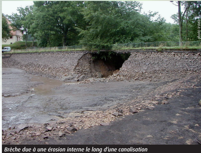
Brèche due à une érosion interne le long d'une canalisation
