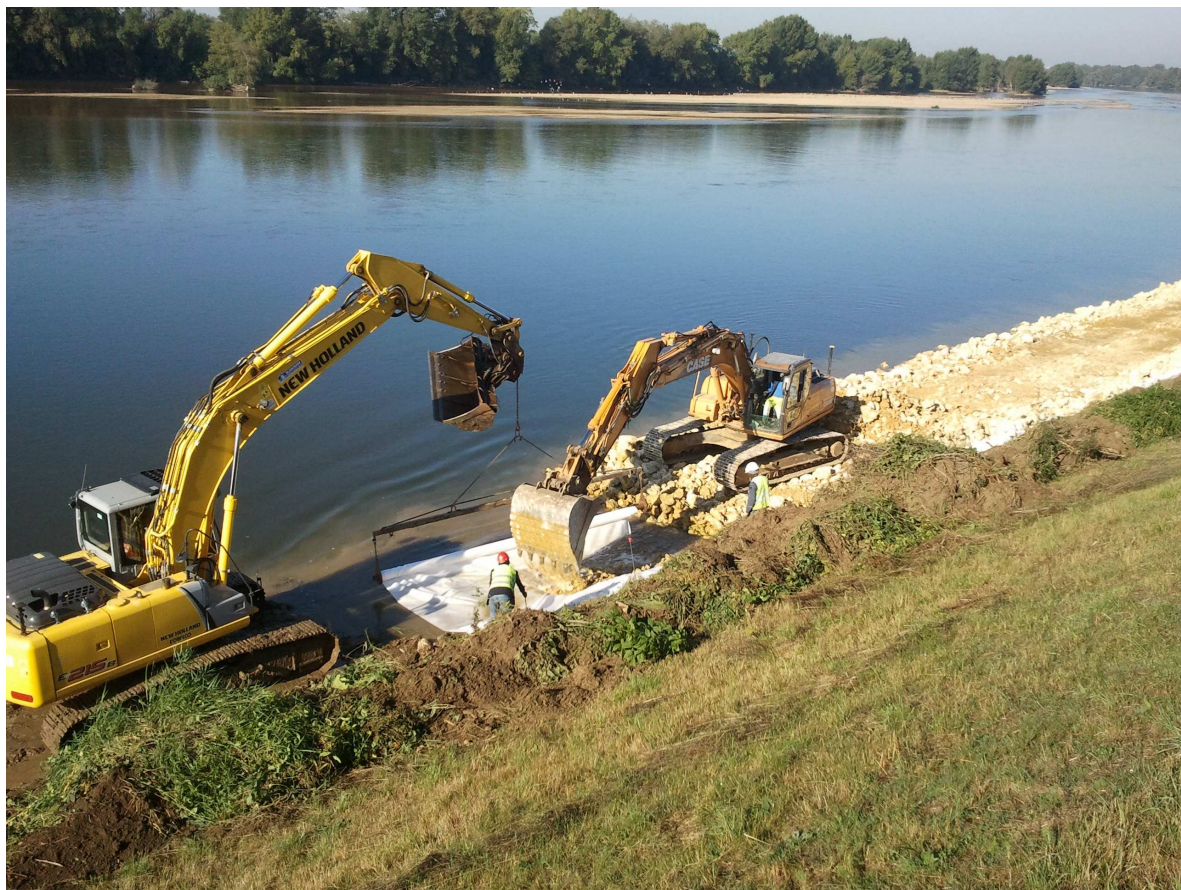
Mise en œuvre du géotextile sous les enrochements, octobre 2013
