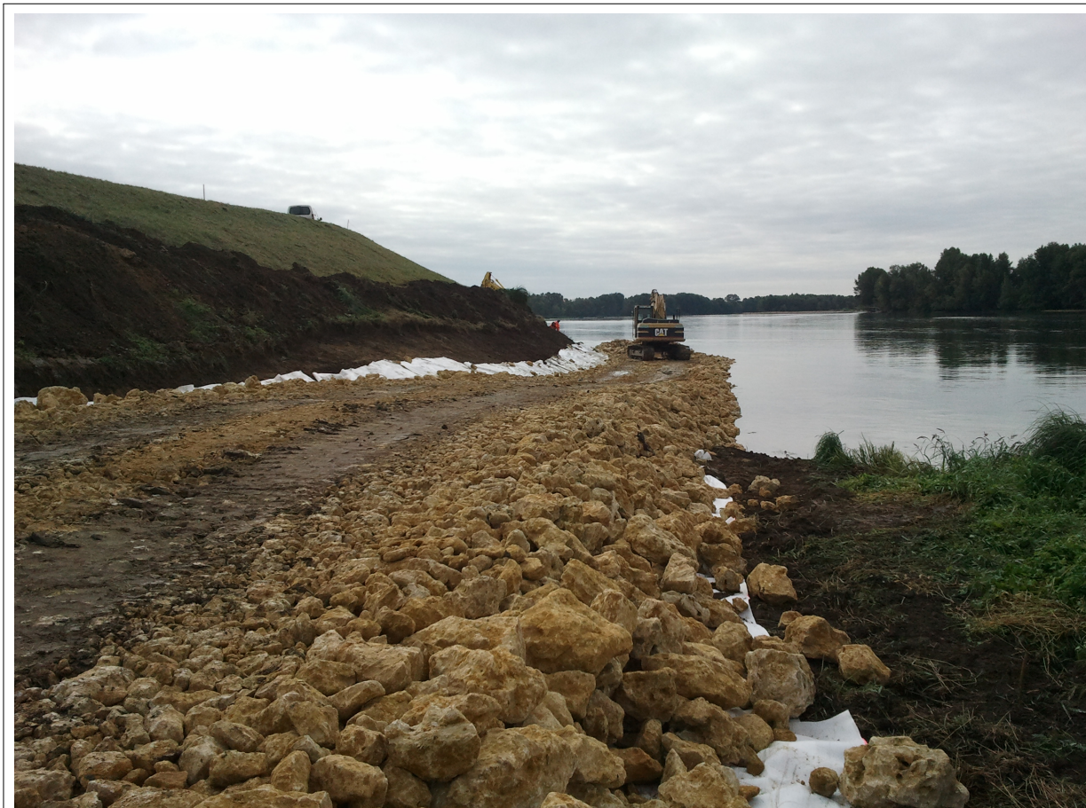
Début des travaux, septembre 2013
