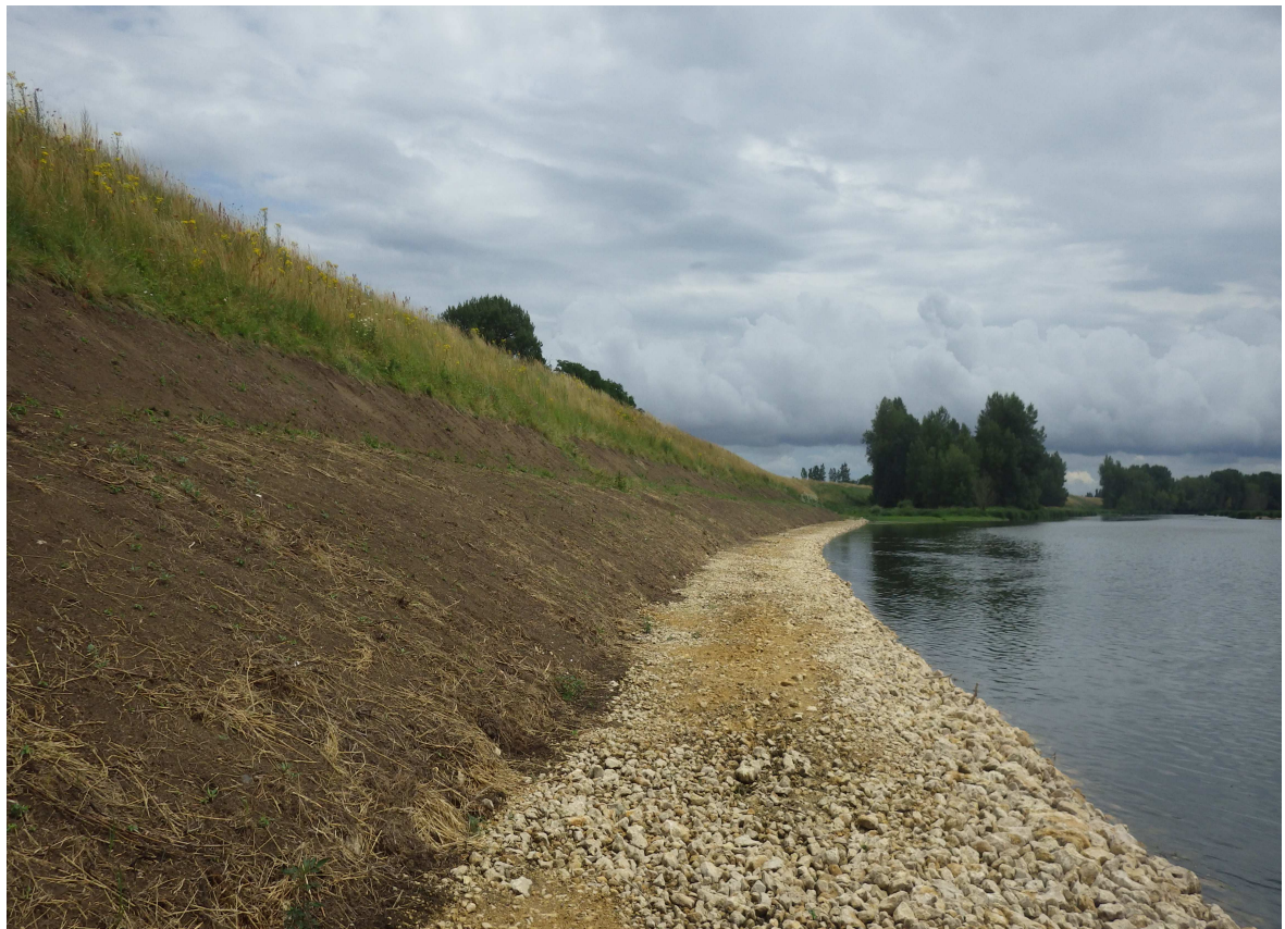
Fin des travaux, juin 2014
