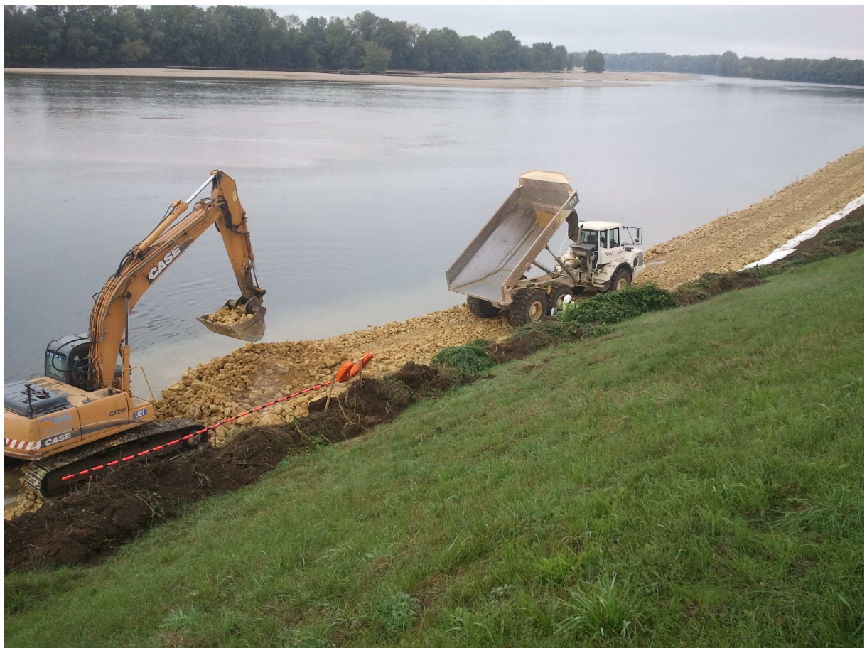
Mise en œuvre des enrochements, octobre 2013
