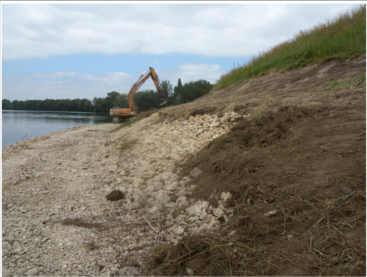
Mise en œuvre de la terre végétale sur la protection du perré, juin 2014
