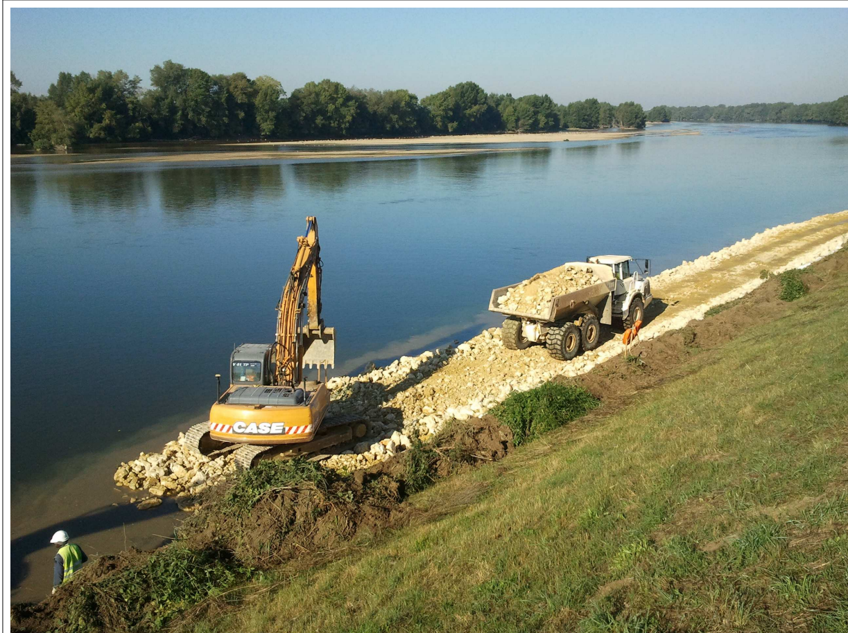
Mise en œuvre des enrochements, octobre 2013
