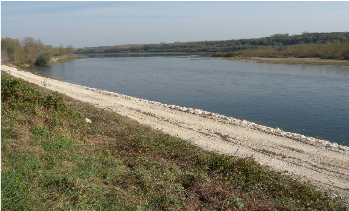
Renforcement en enrochement avec piste d'entretien
