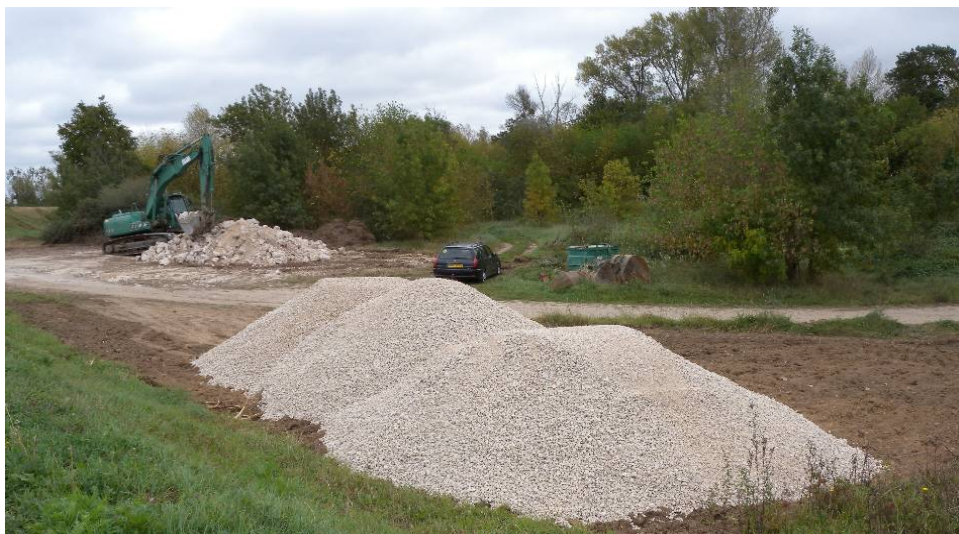
Zone de stockage des enrochements en provenance de carrière
