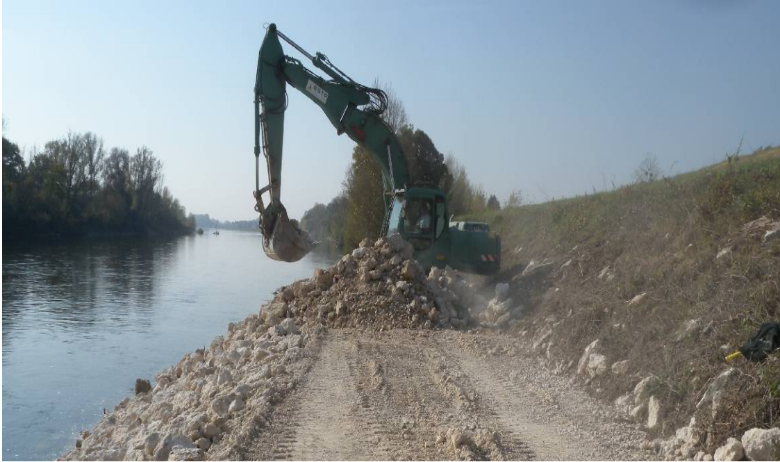
Mise en œuvre des enrochements
