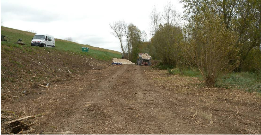
Création d'une rampe et du chemin d'accès à la piste d'entretien
