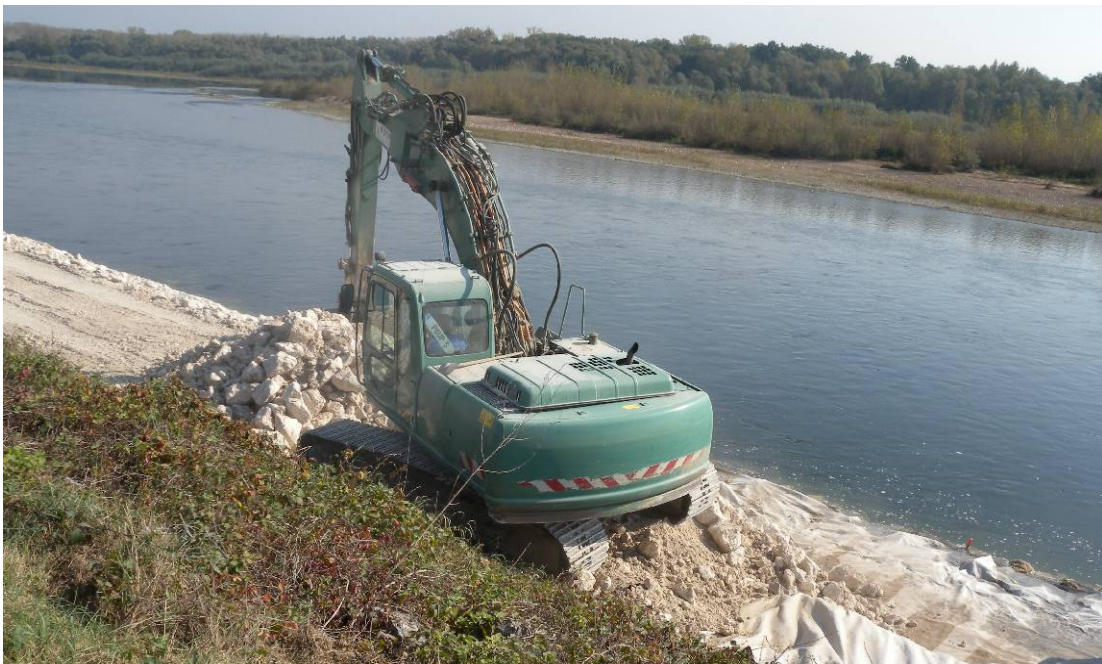
Mise en œuvre du géotextile et des enrochements
