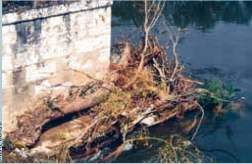
Embâcles accumulés contre un pilier du pont George V
