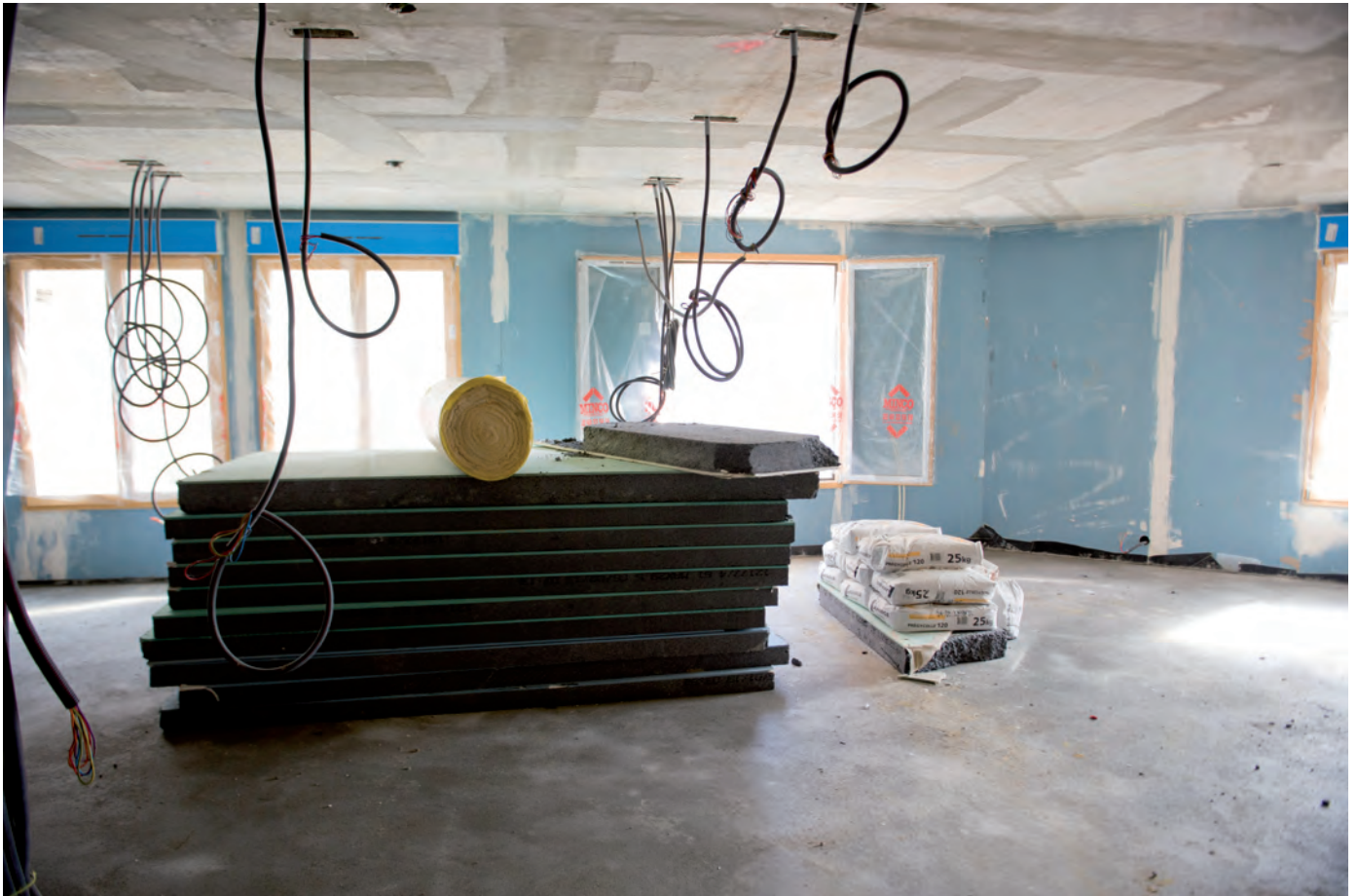
Chantier d'une opération de logement mixte Copyright : © Bernard Suard - Terra
