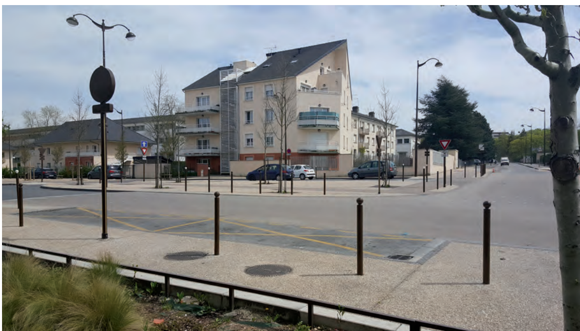
Construction du Programme de Rénovation urbaine à Bourges © SBLAD - DREAL Centre-Val de Loire
