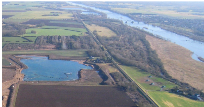
Illustration44-Plan d'eau résultant de l'extraction des alluvions dans le lit majeur de la Loire
