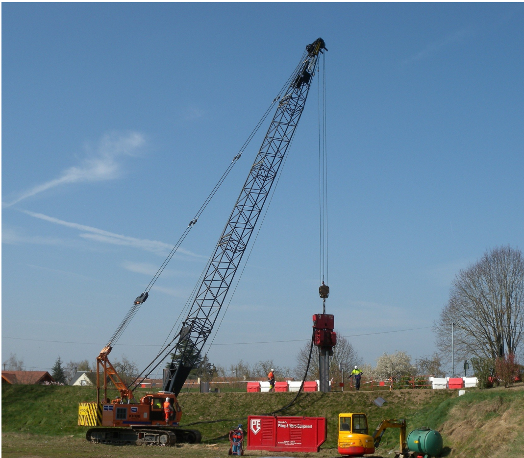
Mise en oeuvre des palplanches
