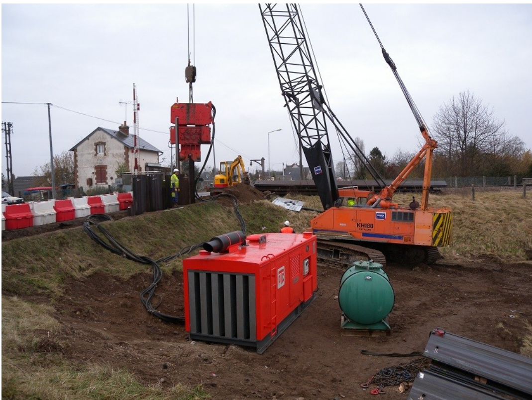
Mise en oeuvre des palplanches
