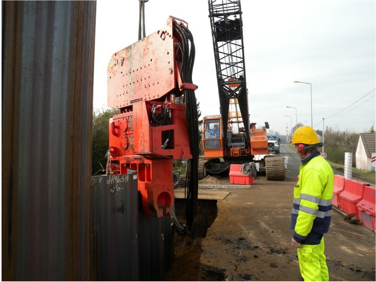
Le vibro-fonçage d'une palplanche
