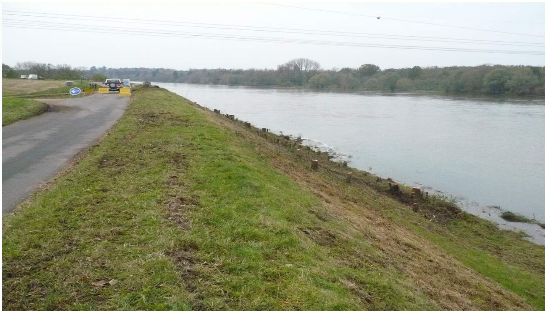
Le site après les travaux
