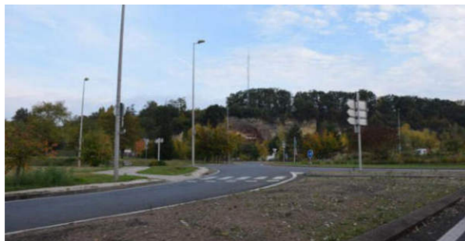
Caractère très routier (signalisation, mobilier d'éclairage) des aménagements du rond-point entre les RD952 et RD953 à l'entrée de Cinq-Mars-la-Pile
