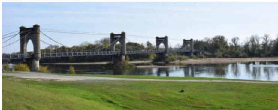
Le pont suspendu de Langeais, seul franchissement routier possible de la Loire sur cette séquence
