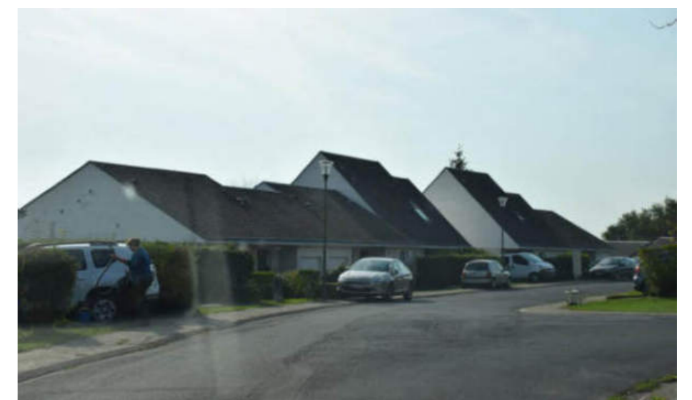
On retrouve des emprises routières (enrobé) trop importantes, et une forme urbaine banalisée peu caractéristique du modèle ligérien. Quartier du Mistrais sur le plateau de Langeais
