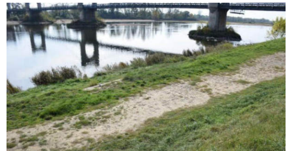
Signes de dégradation des ouvrages maçonnés du port de Langeais
