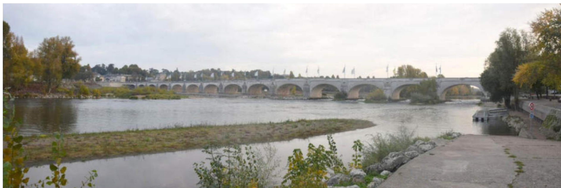
Pont Wilson: directement lié au centre historique de la ville, c'est un élément remarquable du patrimoine du Val
