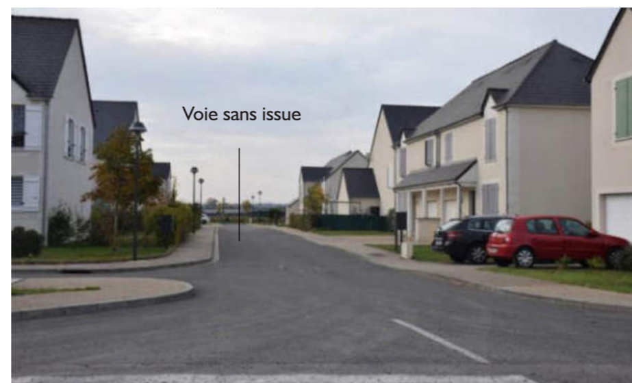
Consommation d'espace, voies d'accès sans issue, absence de mixité des usages, ces phénomènes sont caractéristiques des ces quartiers en marge des centres urbains. La-Ville-aux-Dames
