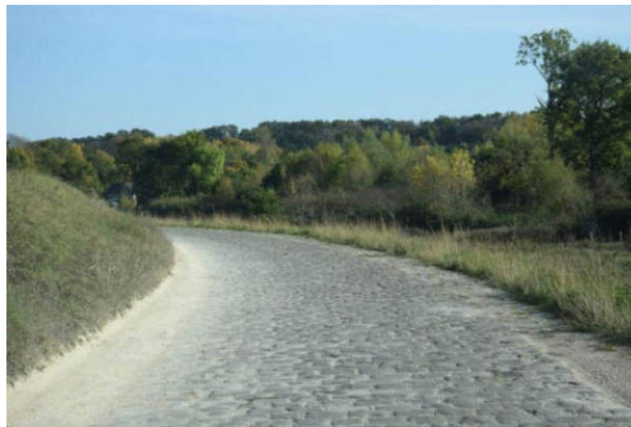
La route RD 16 en pavée sur la levée entre la confluence Loire-Cher et Villandry
