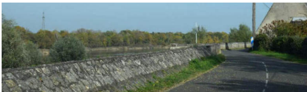
Une levée maçonnée aux abords de La-Chapelle-aux-Naux, trace de l'ancienne activité portuaire
