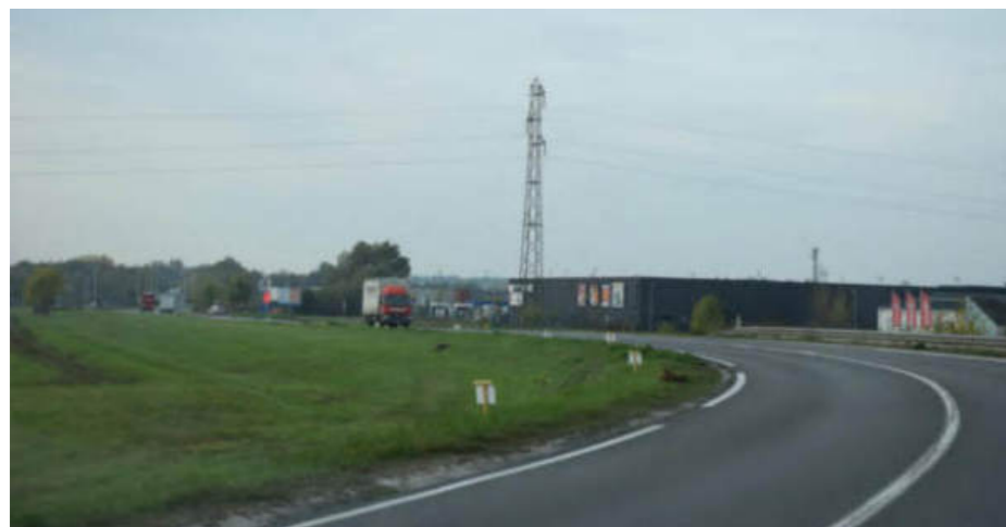
Aménagement technique sur talus de la RD 142 à l'entrée est de Tours
