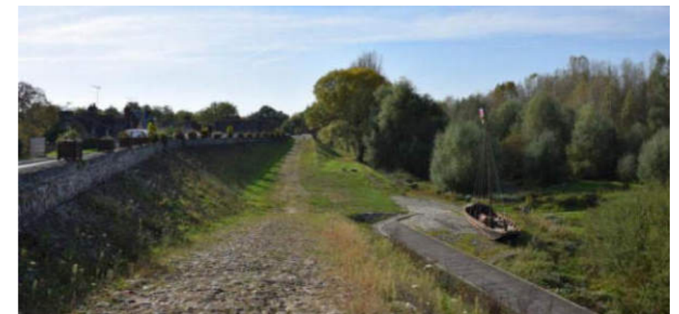
Sur la rive gauche, à la Chapelle-aux-Naux, les ouvrages de la levée sont envahis par une végétation spontanée
