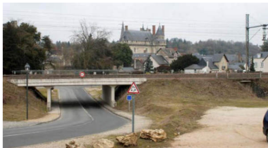
Entrée de ville trop technique et peu accueillante, Langeais
