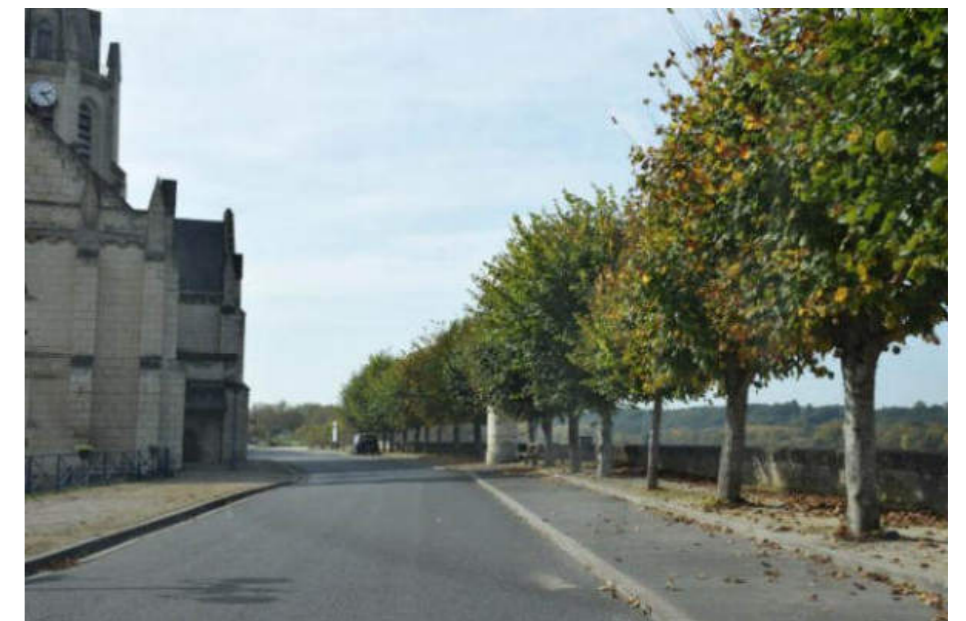
Un alignement de tilleuls souligne le front de Loire à Bréhémont
