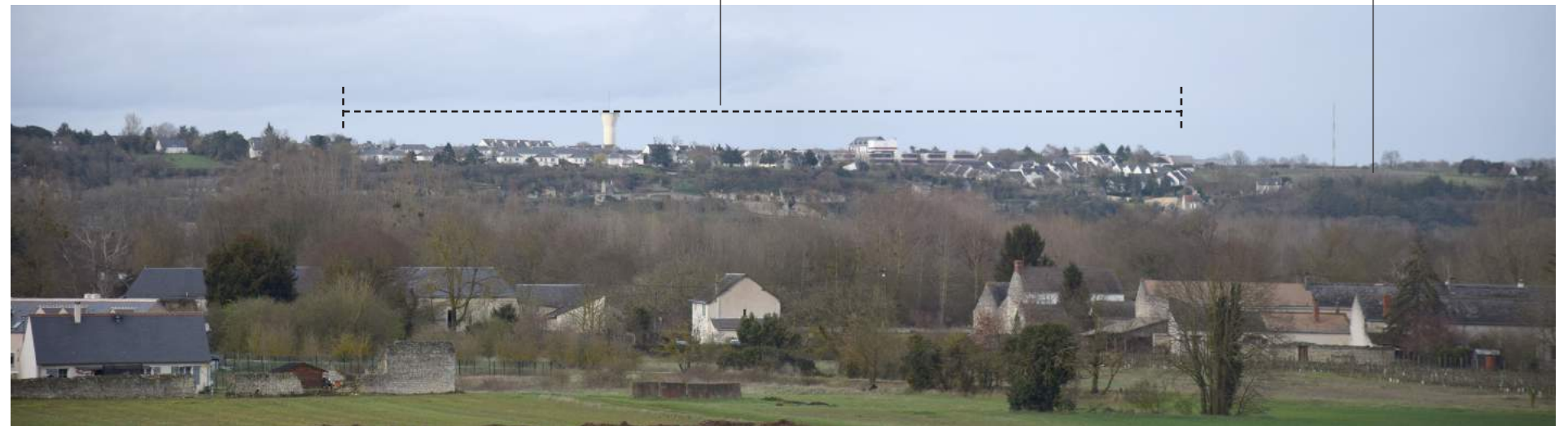
Rebord de coteau fragilisé du plateau Saint-Jean, au nord-est de Chinon, depuis le coteau sud de la Vienne
