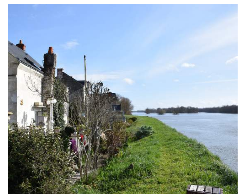
La levée protège le bâti implanté juste derrière, La-Chapelle-sur-Loire
