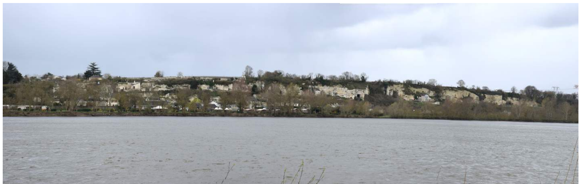
A partir de Candes-Saint-Martin s'offre, en rive gauche, les paysages pittoresques des fronts bâtis du Saumurois alternent entre falaises de tuffeau brutes ou ciselées par les habitats troglodytiques
