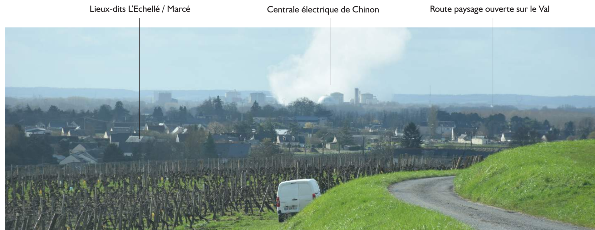
La centrale électrique vue depuis le coteau viticole, lieu-dit L'Echellé, Bourgueil
