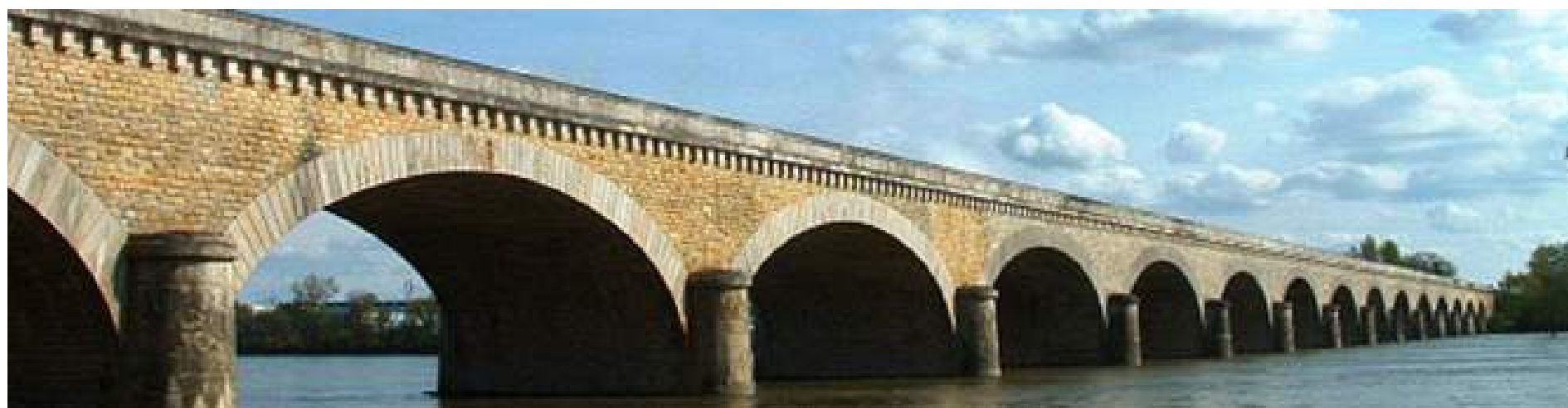
Construit entre 1874 et 1876, le pont voûté maçonné de Port-Boulet, long de près de 500 m et rythmé par seize arches
