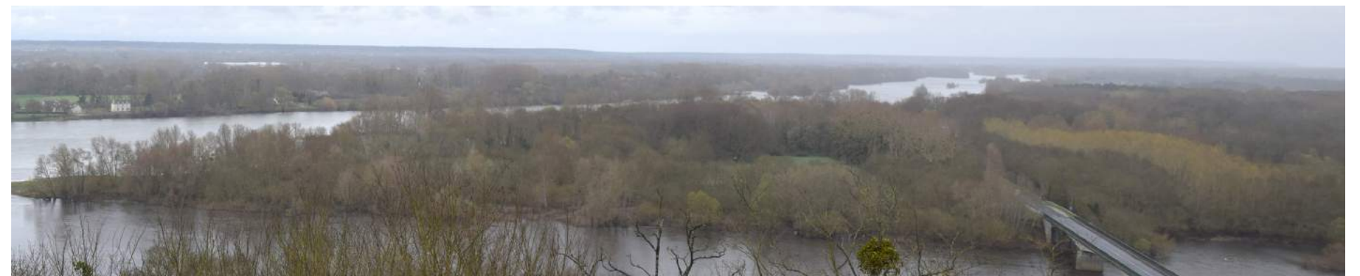
La pointe du Véron à la confluence Loire / Vienne, un espace cloisonné par la végétation
