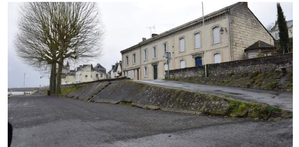
Dégradation des ouvrages du port de Montsoreau
