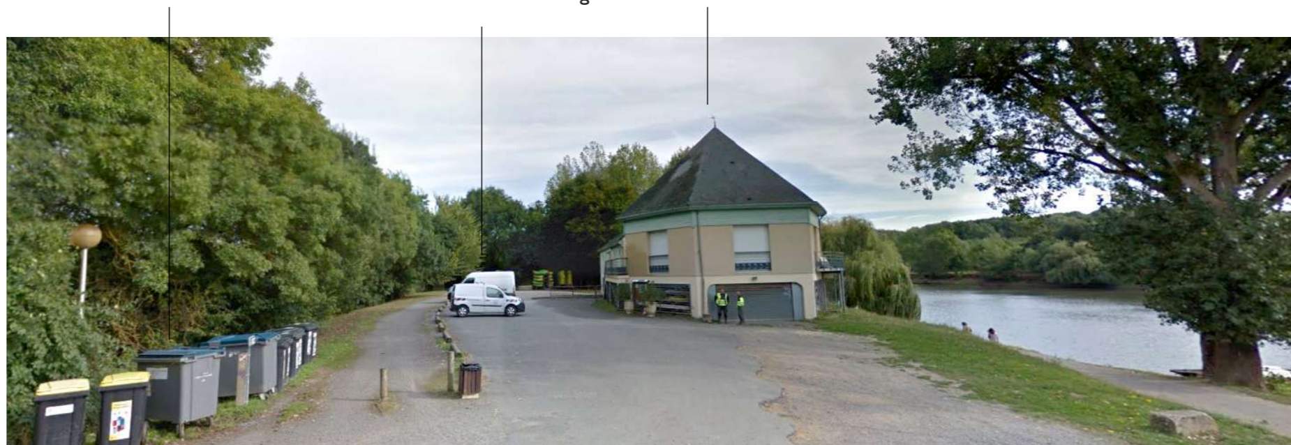
Club nautique de Bouchemaine, un bâtiment et des abords qui nuisent à la qualité paysagère de cette séquence des rives de la Maine
