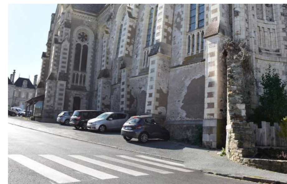
Le stationnement au pied de l'église de Rochefort-sur-Loire nuit à la mise en valeur de l'édifice
