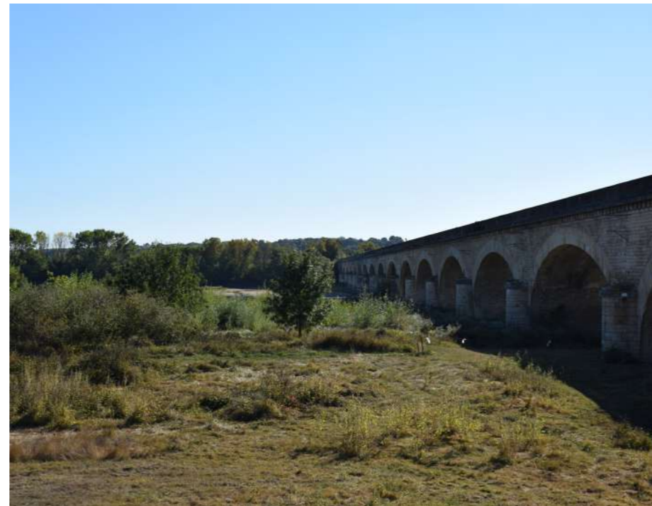
Viaduc ferroviaire à la Possonnière
