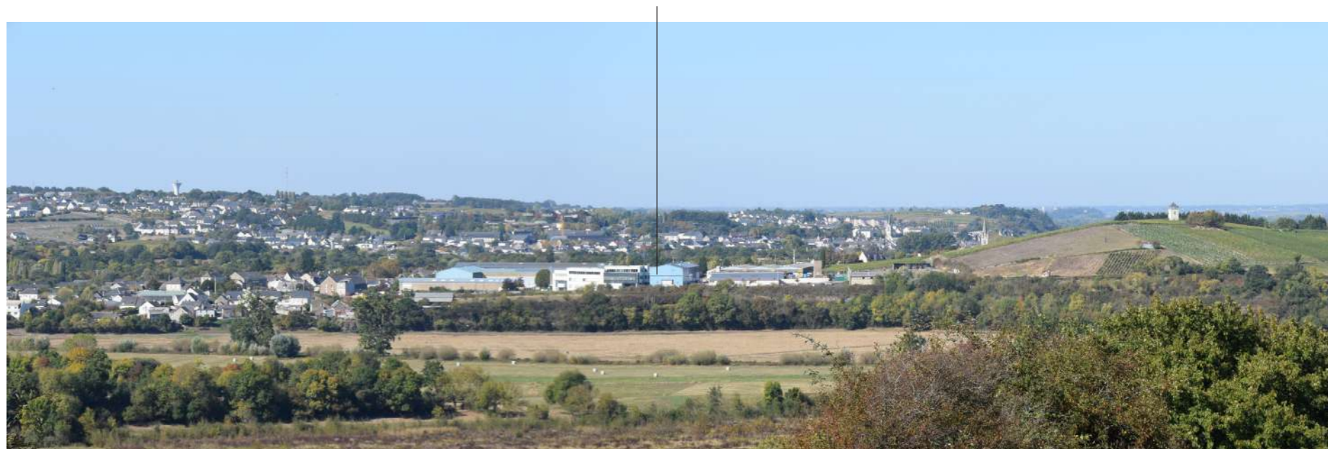
Les volumes imposants des bâtiments d'activités rendent la zone de la gare de Chalonnes-sur-Loire particulièrement visible dans le paysage de la vallée du Layon, notamment depuis les hauteurs de la Corniche Angevine
