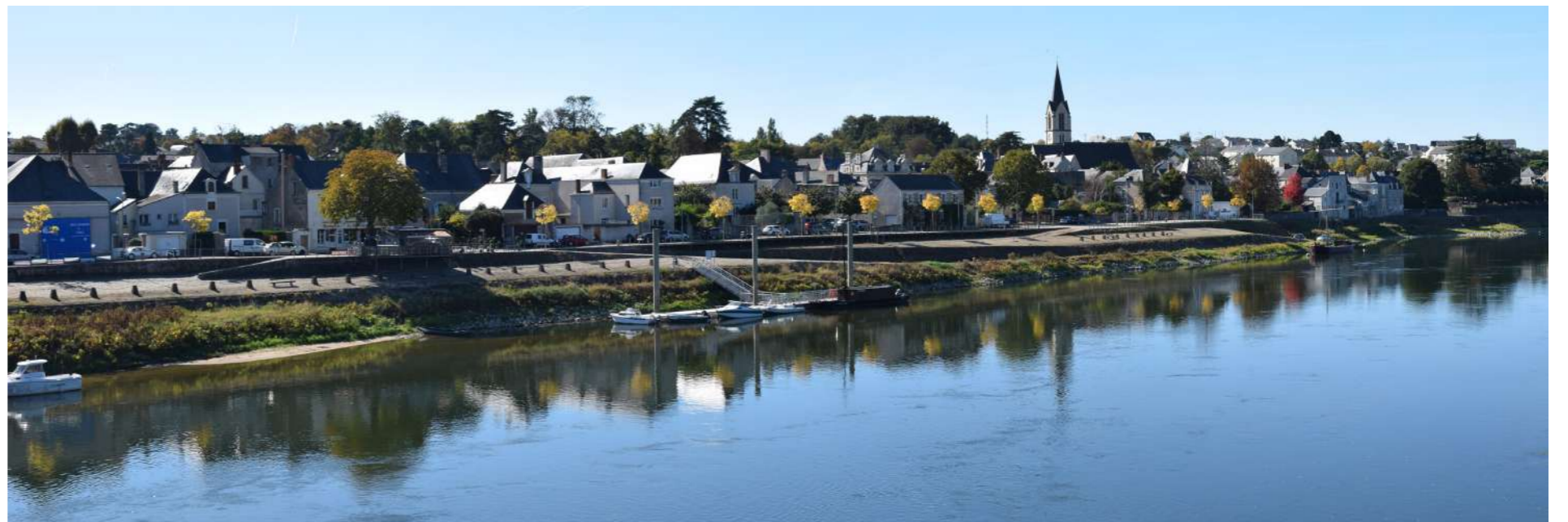
Façade fluviale de Chalonnes-sur-Loire
