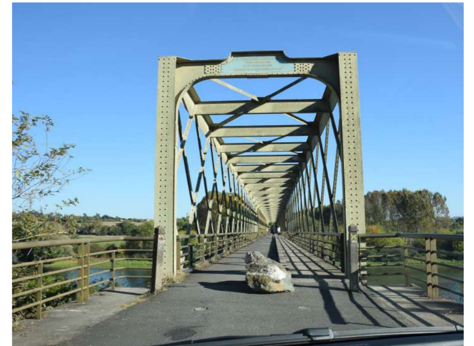
Pont métallique de Bouchemaine pour franchir la Maine, aujourd'hui réservé aux circulations douces
