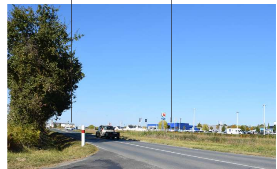
Architectures commerciales dévalorisant la voie d'arrivée à Saint-Georges-sur-Loire et la perspective sur l'église Saint-Georges.
