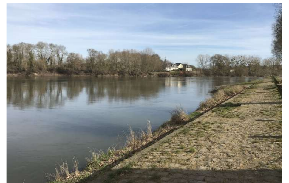
Port de Béhuard, fragilisation des quais en pavé par une végétation spontanée
