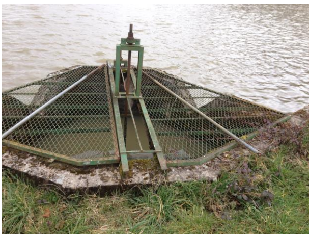
Ouvrage de trop-plein / vidange existant sur le plan d'eau Aval
