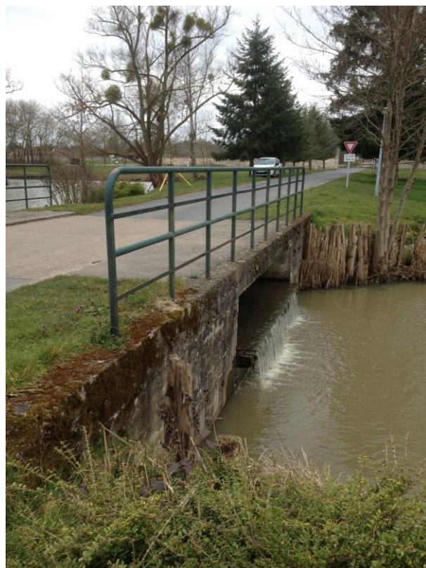
Ouvrage de Trop-plein du plan d'eau Amont vers le plan d'eau Aval
