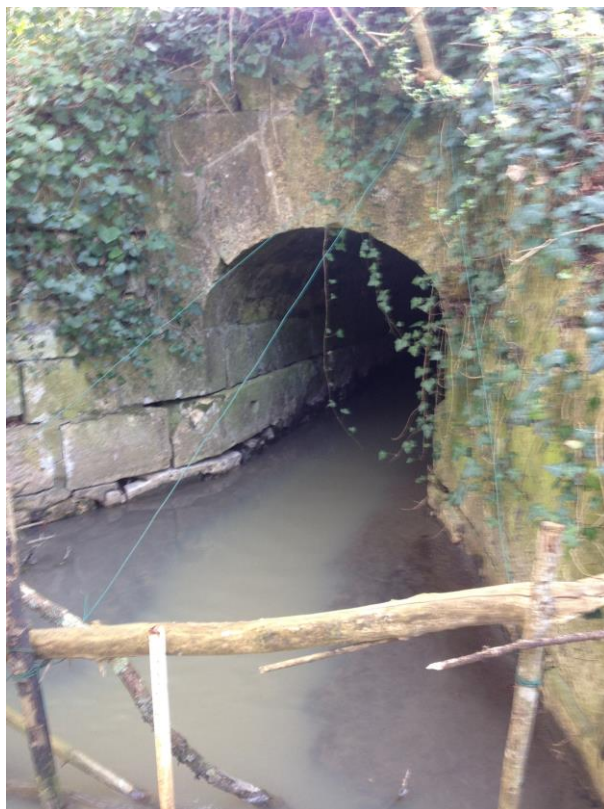
Sortie des eaux des plans d'eaux vers le Vernisson (ouvrage voûté)
