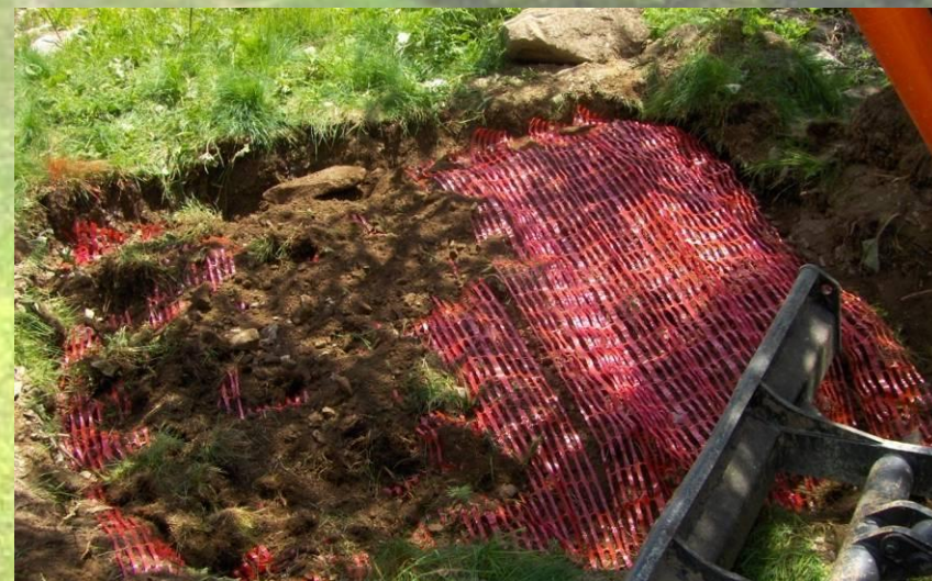
5- Remblaiement des paniers et repérage
