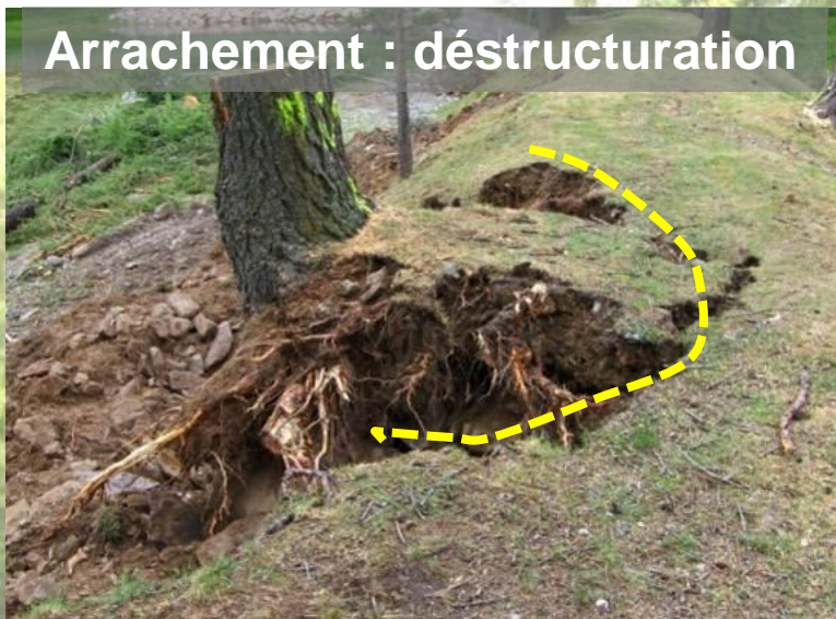
Dégradation des perrés
