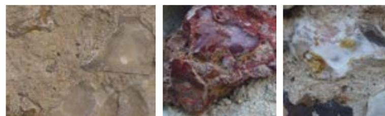
**Le silex** est une spécificité géologique du Sancerrois. Il se mêle au tout-venant dans l'édification des murs, aux côtés des moellons de grès et de calcaire. Sancerre comporte quelques exemples remarquables de maçonneries en silex dont les colorations sont variées et parfois étonnantes.
