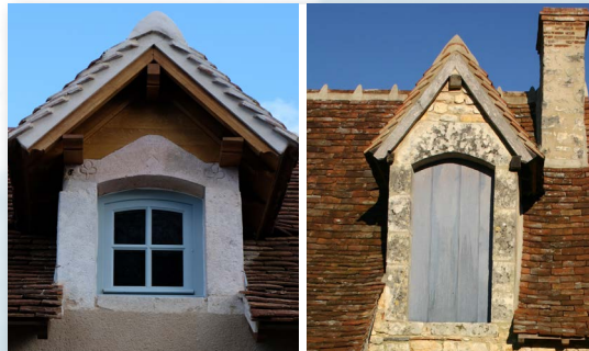
5 Lucarne, jour ou porte, avec jambages en pierre ou en bois, couverte de tuiles.
