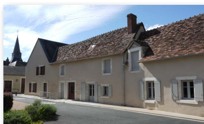
Immeuble Petit-Jean Rivarences (2013-2015)
