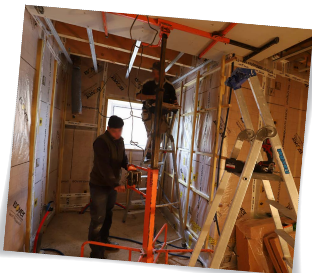
Projet de rénovation d'une longère - Lurais (36)
